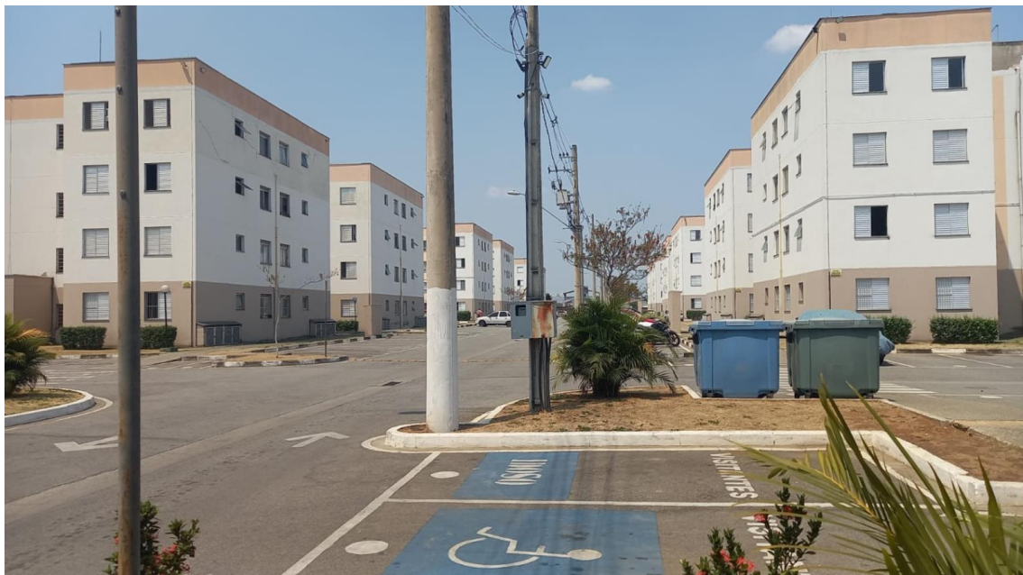
Fotos 03. Vista Interna do Condomínio Jacarandá
