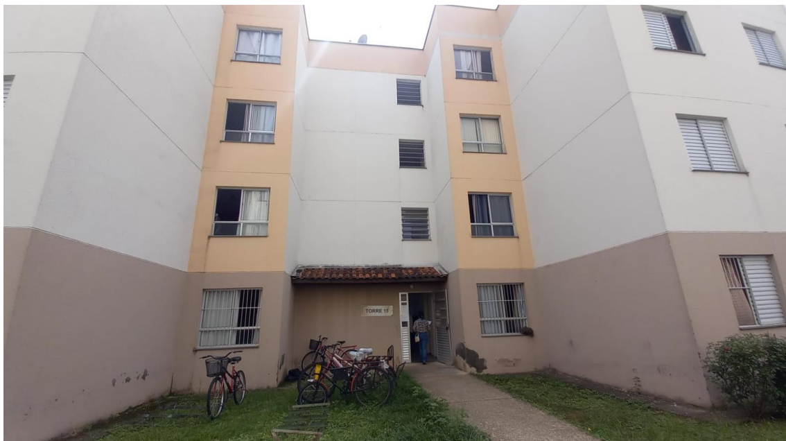
Foto 06. Vista do acesso a Torre 15.
