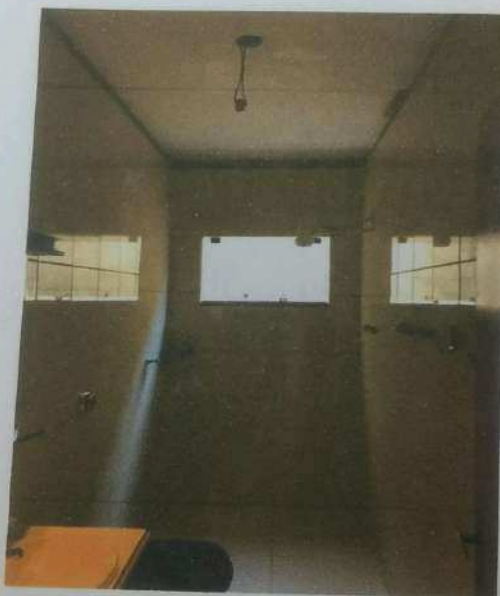
Foto 11 - Banheiro piso superior
