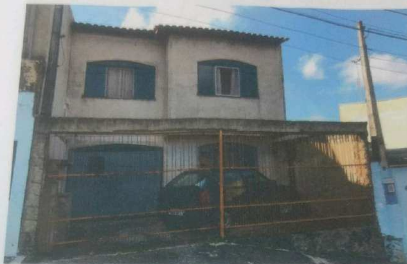
Foto 02 - Fachada do Imóvel Avaliado
