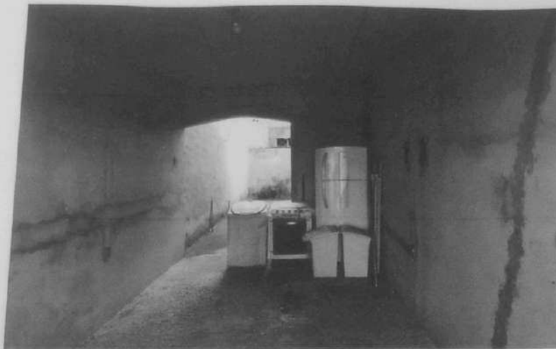
Foto 12 - Corredor Lateral Externo
