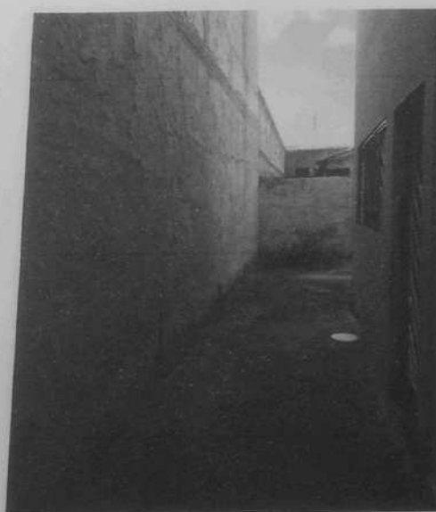
Foto 13 - Corredor Lateral externo 2
