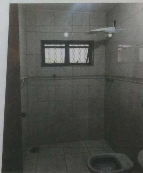
Foto 05 - Banheiro social pavimento térreo
