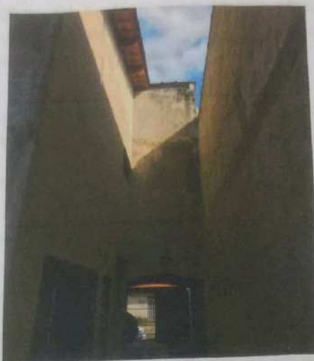
Foto 16 - Parede lateral externa
