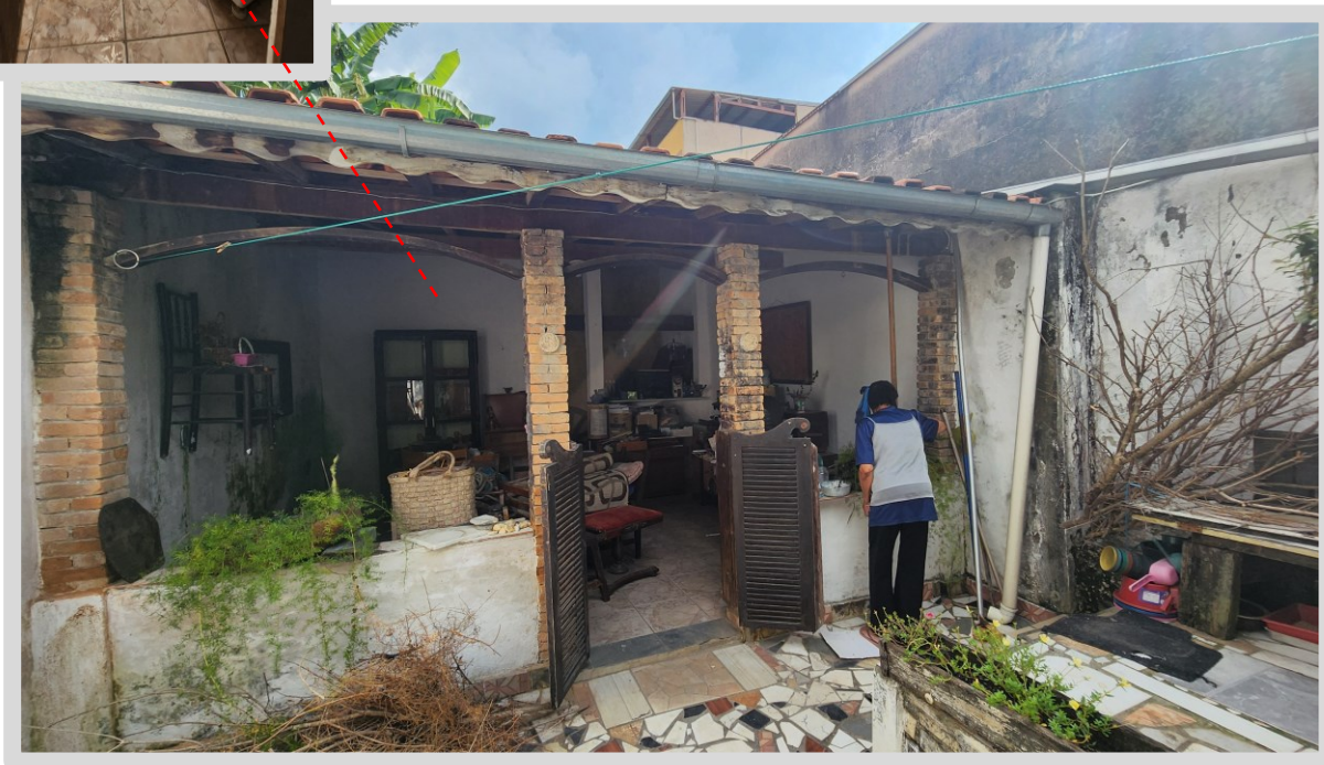
Edícula com sanitário no quintal.
