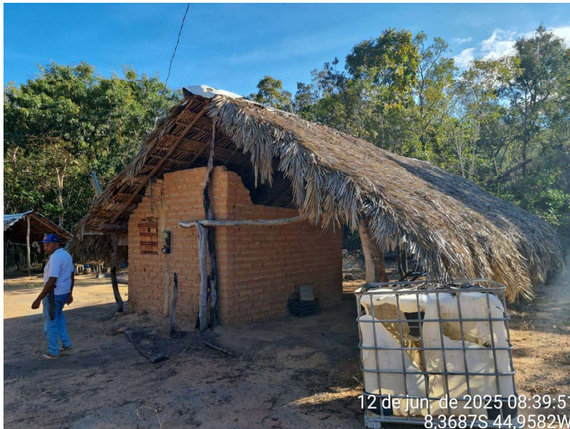
Outro - Foto georreferenciada da entrada do imóvel.
