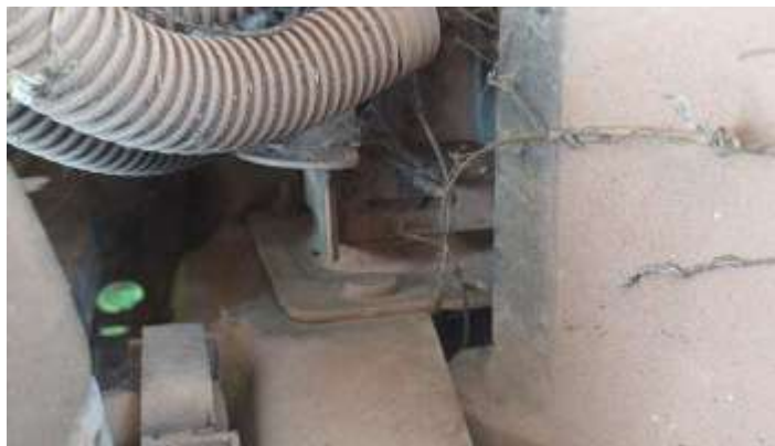
Foto Estrutura Longarina Esquerda
