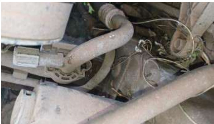
Foto Estrutura Longarina Direita
