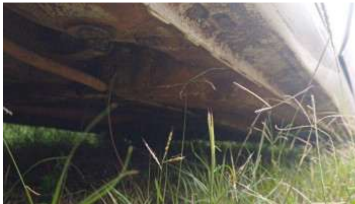
Foto Estrutura Assoalho
