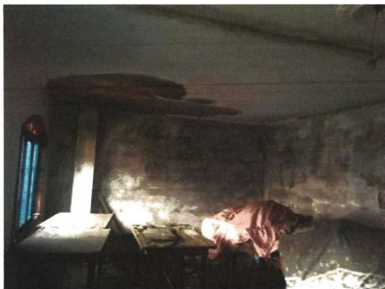
Foto 21 – Vista interna da edícula.
