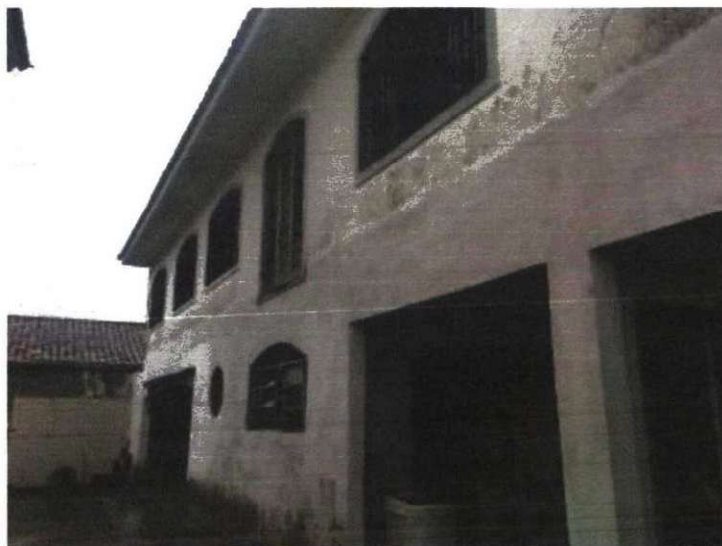
Foto 20 – Vista externa da edícula.
