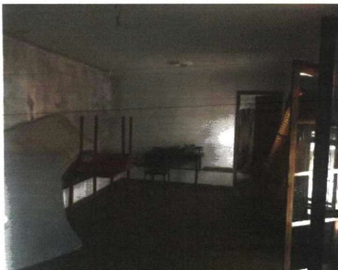
Foto 23 – Vista interna da edícula.
