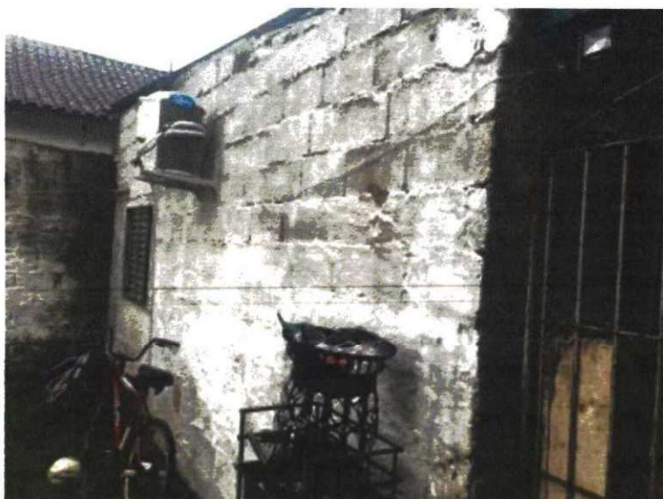
Foto 5 – Detalhe da construção nos fundos do terreno.
