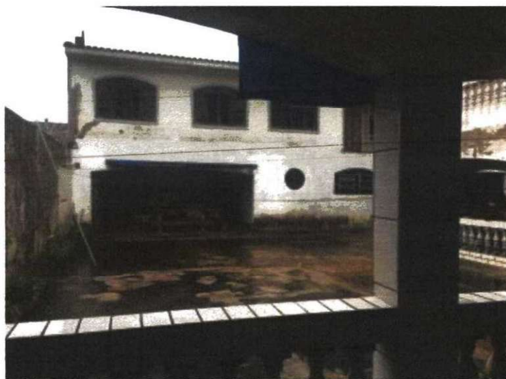
Foto 13 – Vista da fachada nos fundos da edificação principal.
