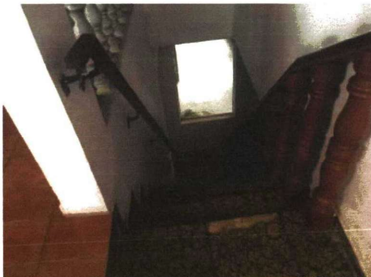
Foto 14 – Vista da escadaria do imóvel.
