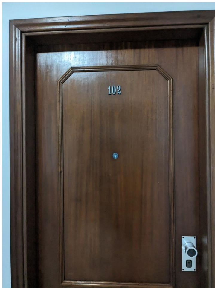
Foto 4 – Porta de entrada da unidade avalianda – nº 102 no 12º andar
