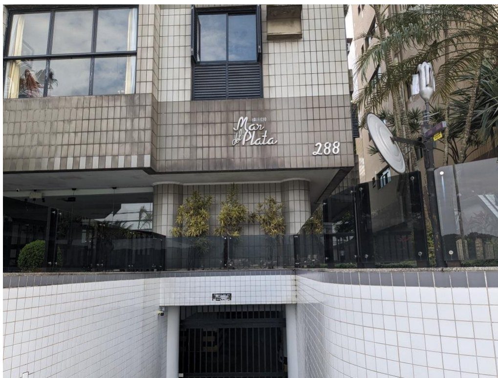
Foto 2 – Identificação e emplacamento do edifício
