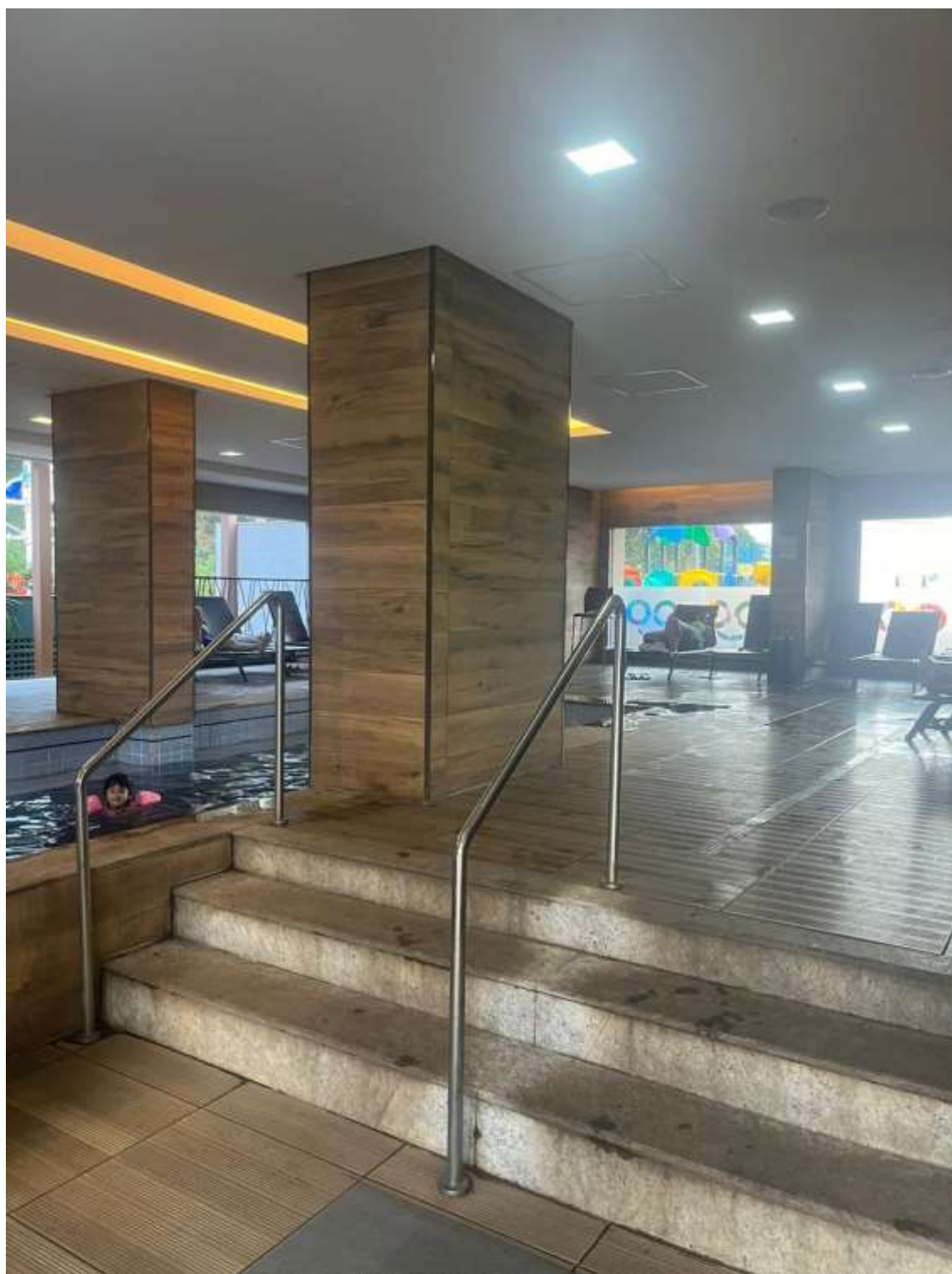
Foto 75 – Vista geral da piscina coberta.
