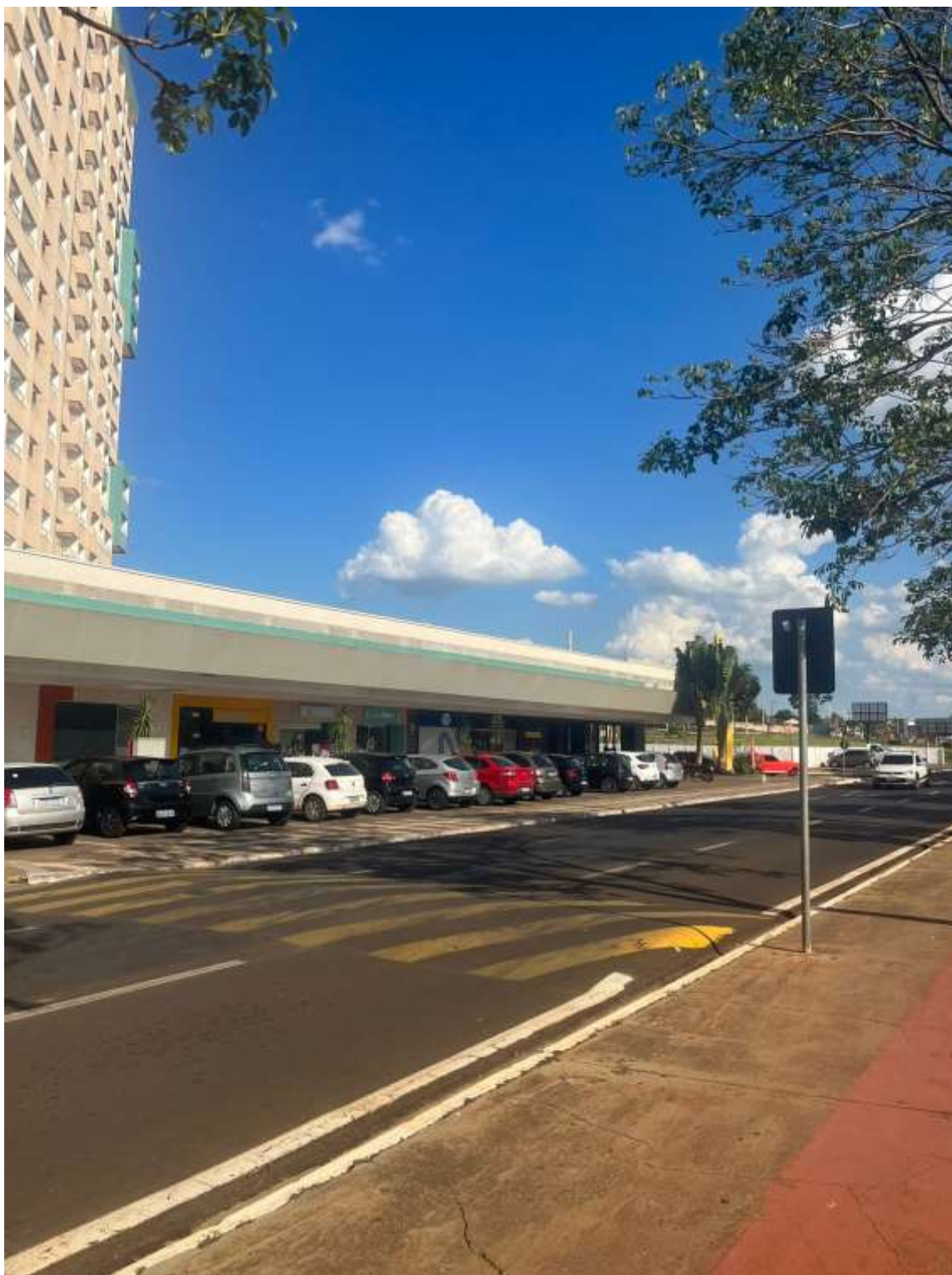
– Vista frontal do Olímpia Park Resort onde está localizado o imóvel objeto desta avaliação, outro ângulo, frente da Av. Aurora Forti Neves – Olímpia Park Resort - Santa Efigênia, Olímpia – SP.
