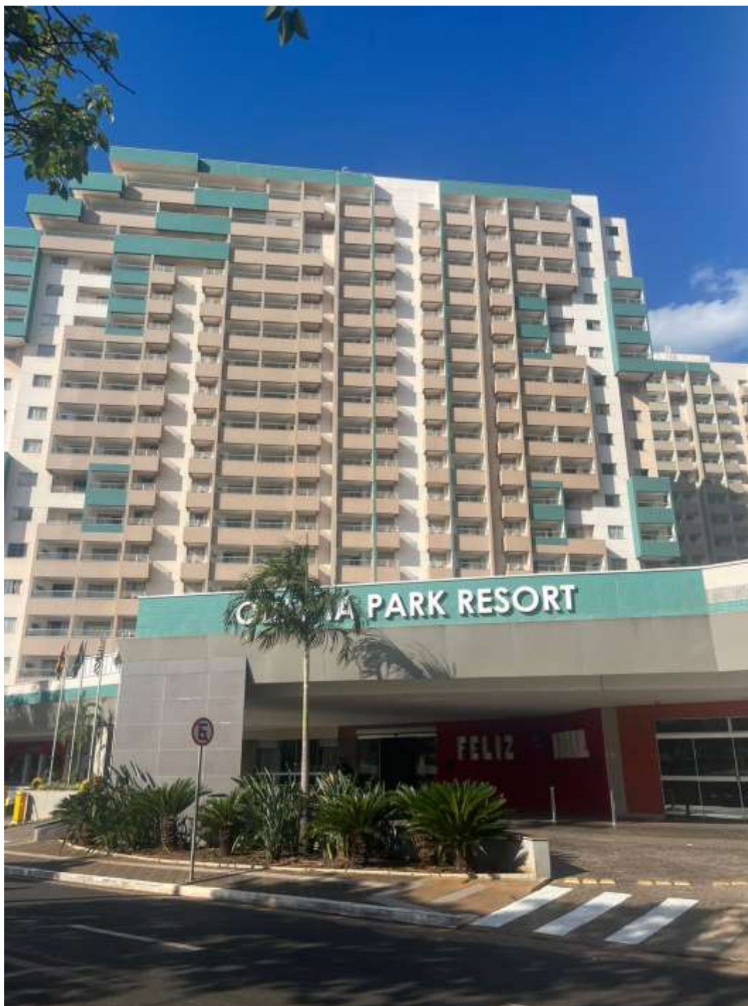
Figura 1 – Vista Frontal do Olímpia Park Resort, onde está localizado o imóvel objeto desta avaliação – Bloco “C” – apartamento 102 – Cota 02.
