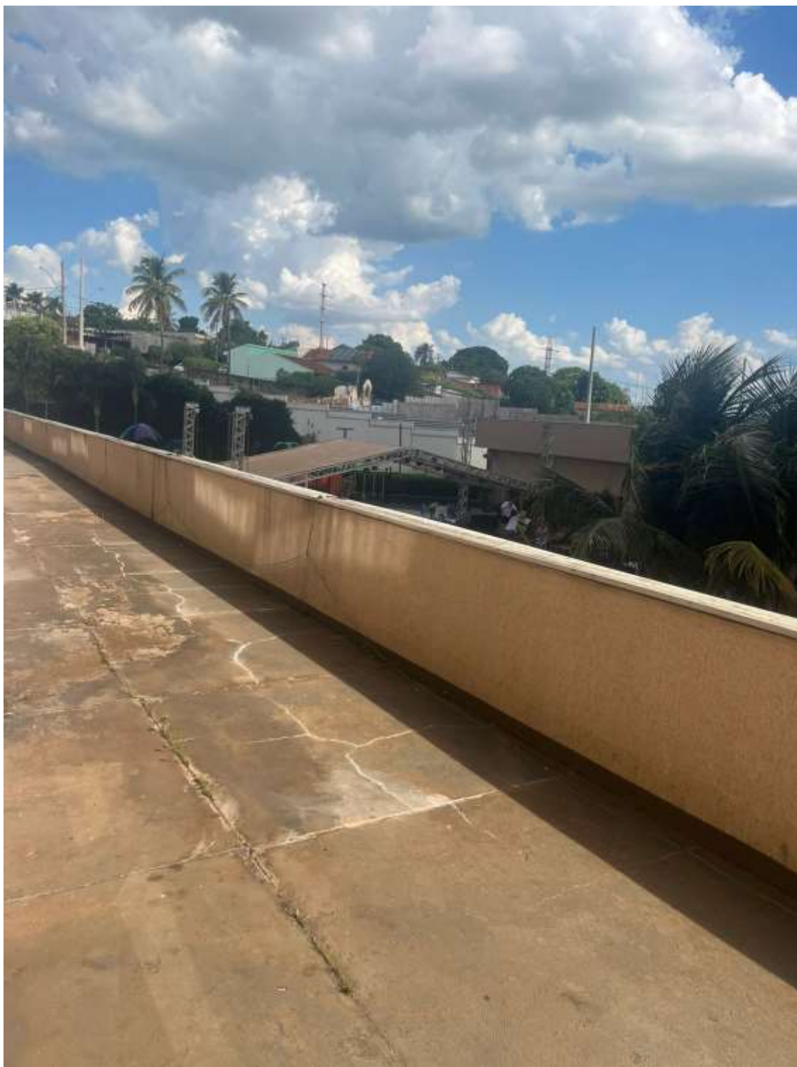
Foto 26 – Vista geral da laje técnica, frente ao apartamento, outro ângulo.
