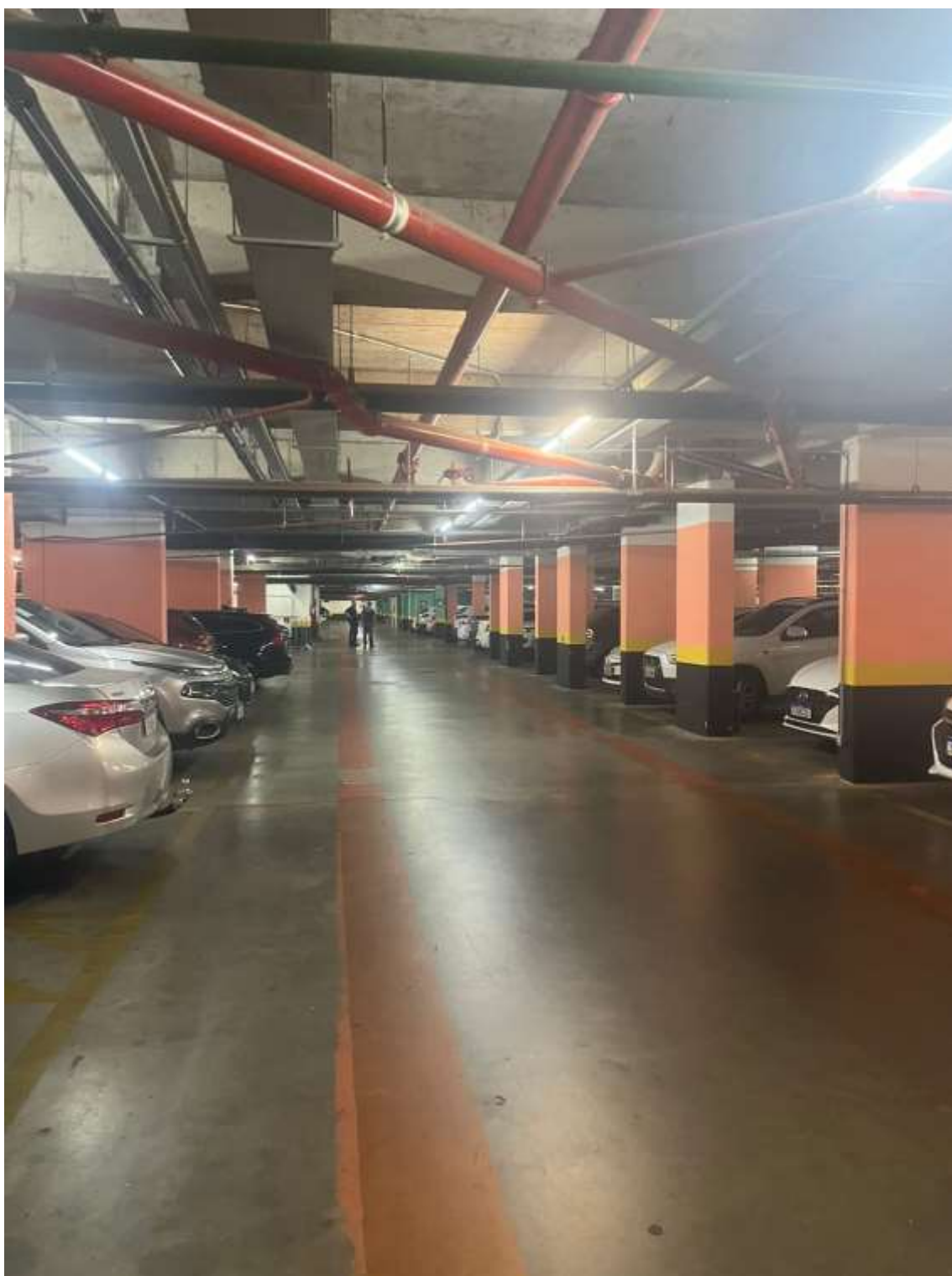
Foto 80 – Vista geral de exemplo de garagem coberta.
