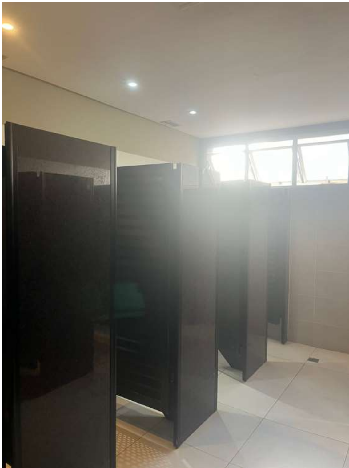
Foto 74 – Vista geral dos banheiros localizados no pavimento térreo, outro ângulo.
