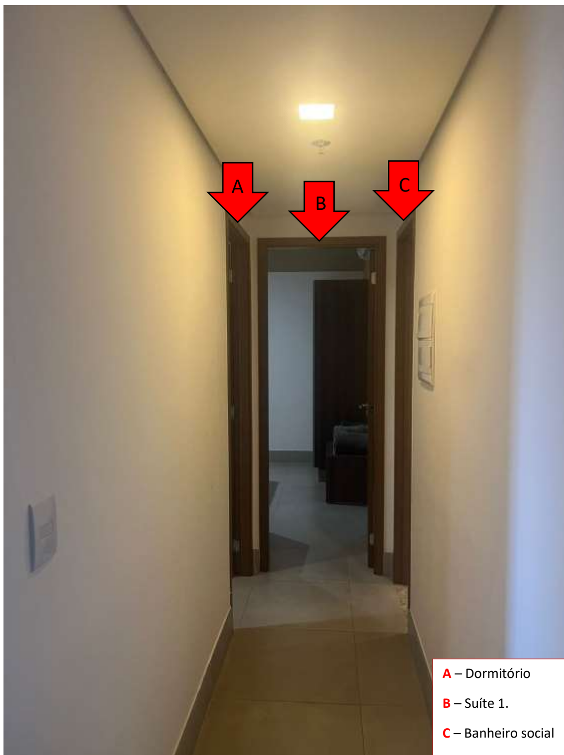
Foto 28 – Vista geral do corredor de acesso aos quartos e banheiro social.
