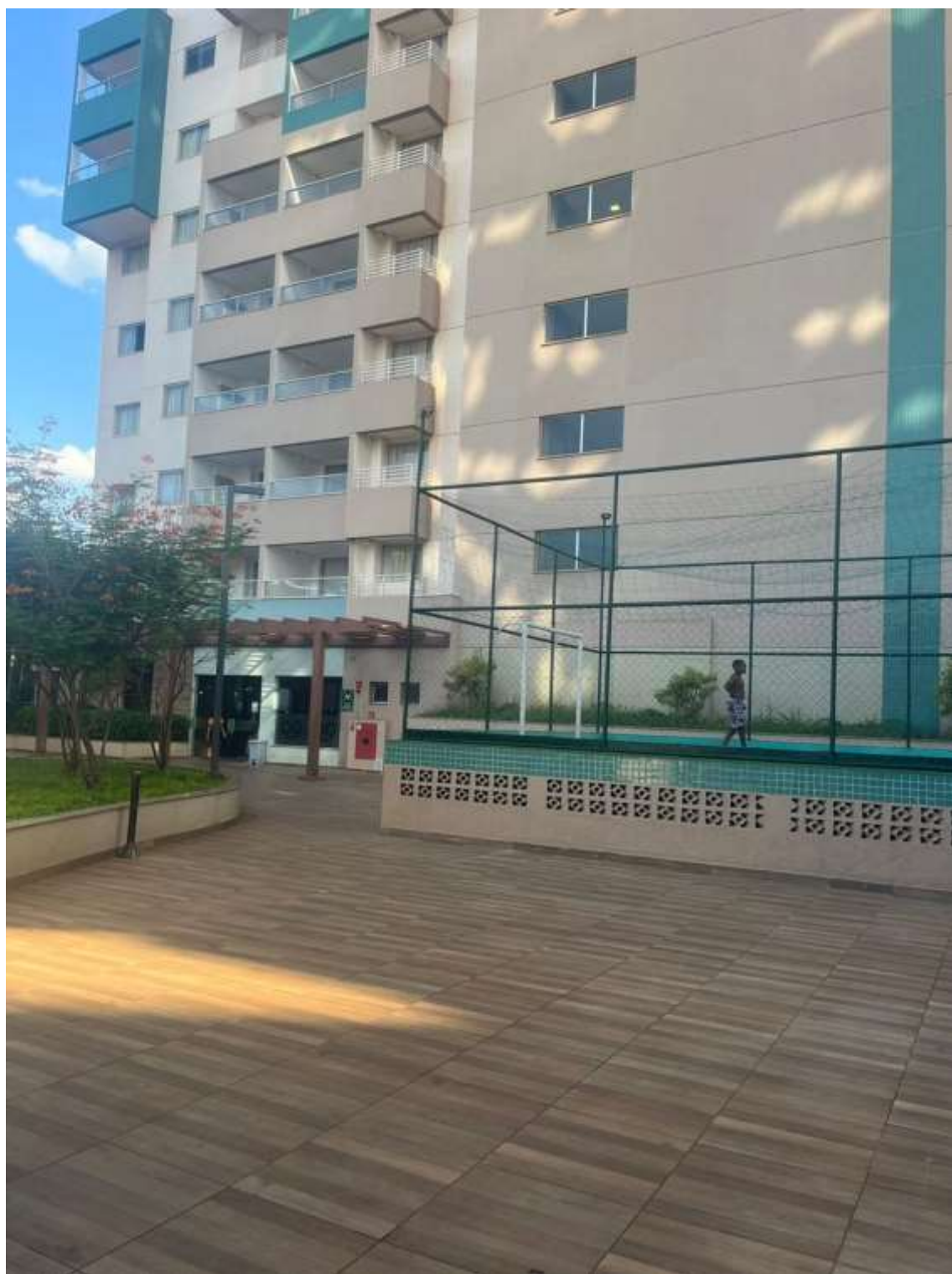
Foto 67 – Vista geral da quadra poliesportiva 02.
