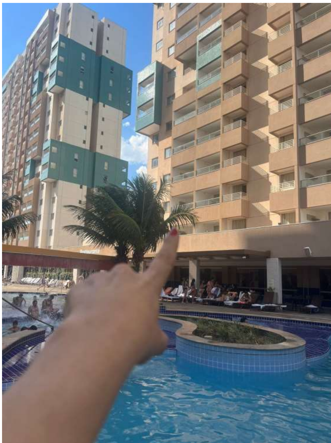
Foto 39 – Vista geral da piscina e indicação do imóvel objeto desta avaliação.
