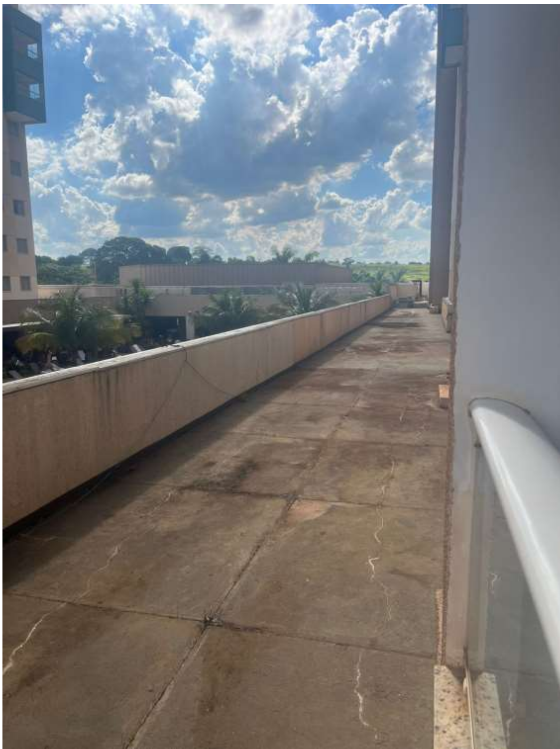
Foto 25 – Vista geral da laje técnica, frente ao apartamento.
