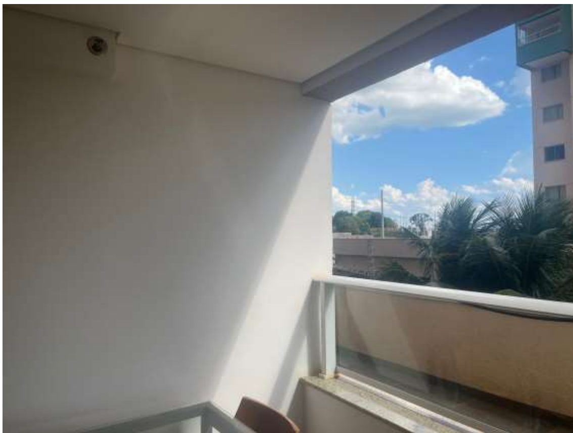
Foto 24 – Vista geral da varanda, outro ângulo. Detalhe de fechamento do guarda-corpo de alumínio e vidro.
