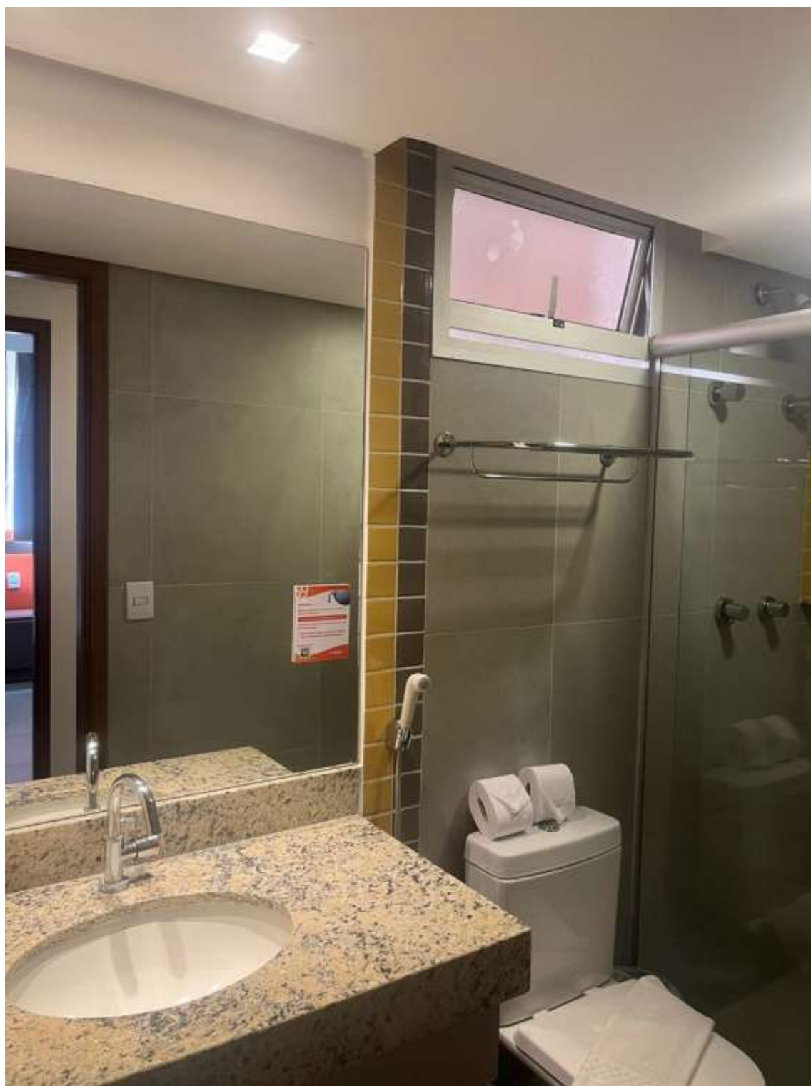
Foto 35 – C – Vista geral do banheiro social.
