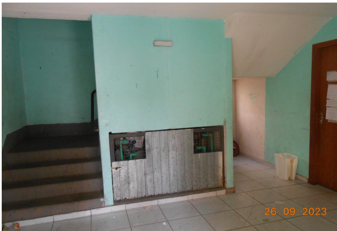
Foto 3: Hall de entrada do bloco G.
