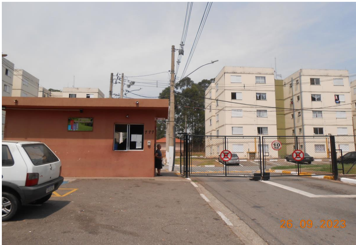
Foto 1: Vista frontal do condomínio.
