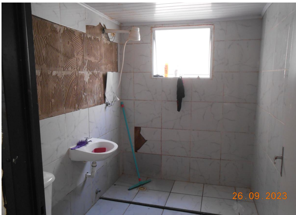
Foto 8: Vista do banheiro social.
