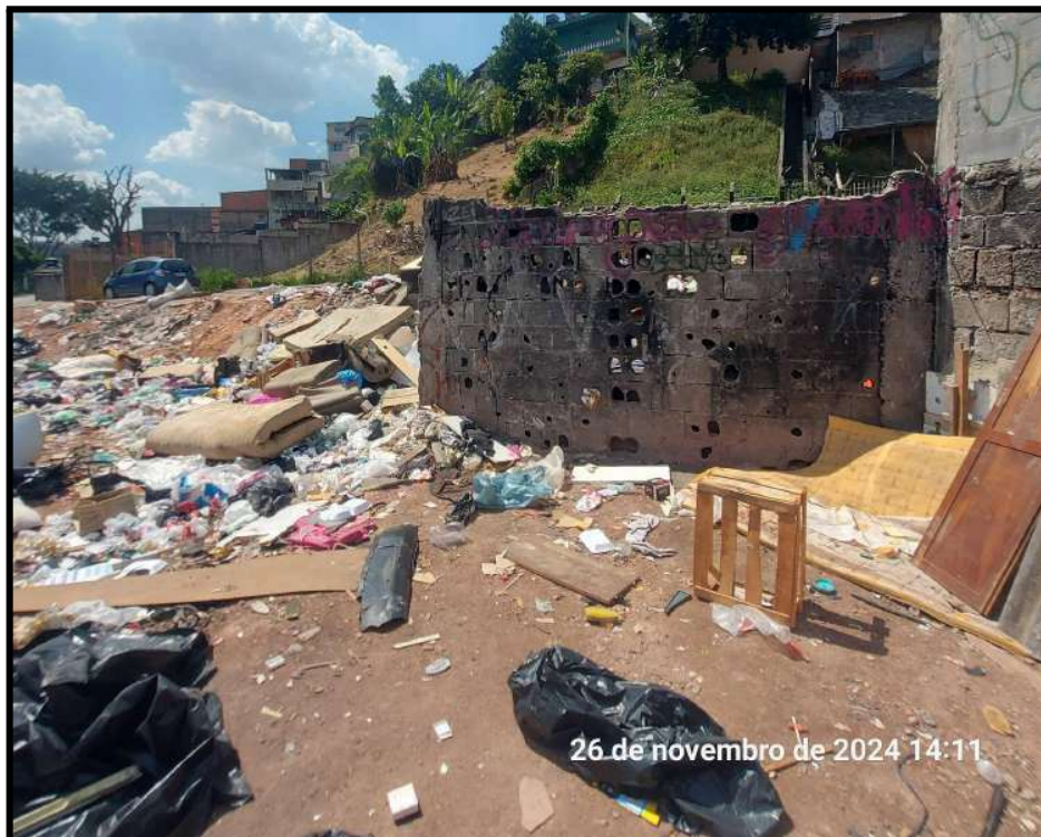
FOTO 08: Vista interna do terreno para a Rua José Rodrigues da Costa
