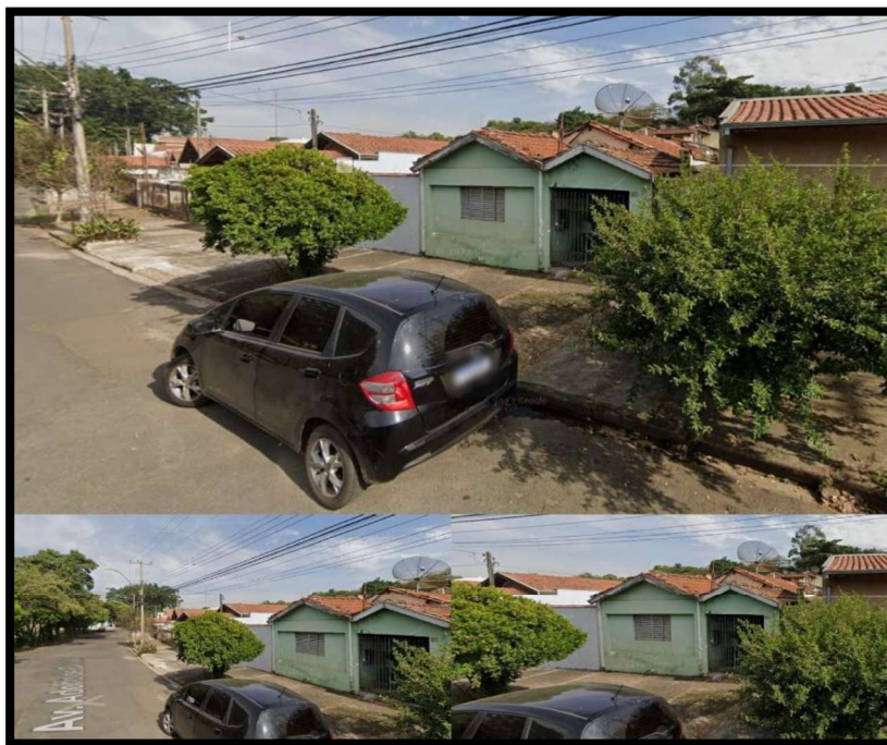
Figura 7 - Fotos do imóvel avaliando (Fonte: google maps)
