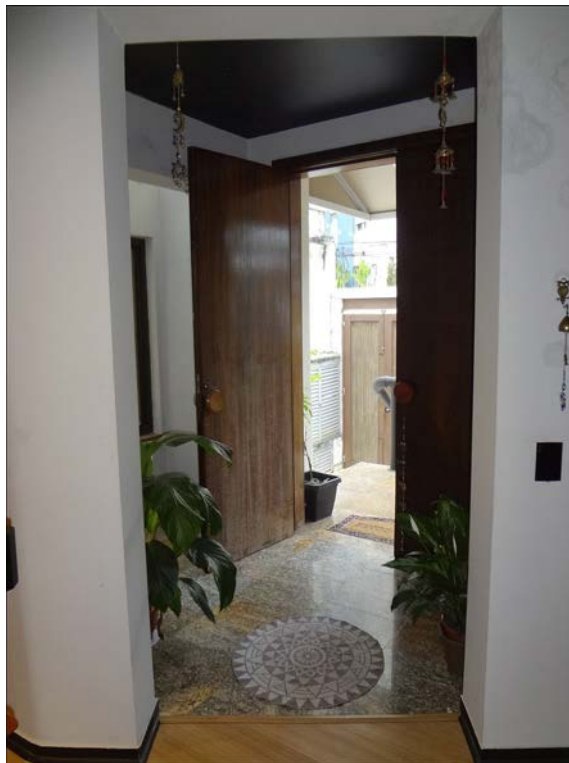
A foto ilustra o hall de entrada (térreo) do imóvel objeto da lide pela Rua Irmão Gonçalo nº 31, no bairro Jardim das Bandeiras.
