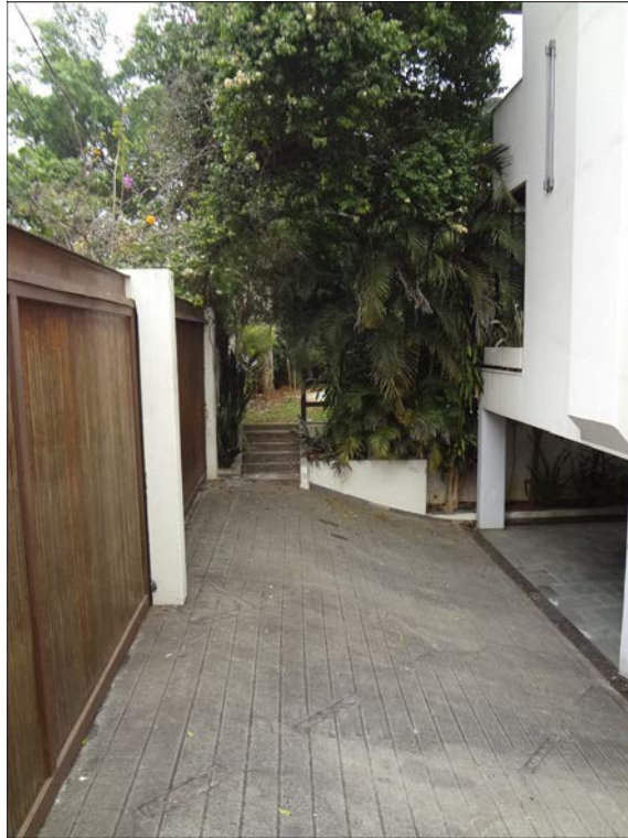
A foto ilustra a rampa de acesso a garagem (subsolo) do imóvel objeto da lide pela Rua Irmão Gonçalo nº 31, no bairro Jardim das Bandeiras.
