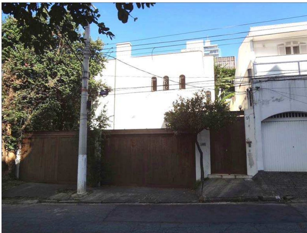
A foto ilustra parcialmente, em 14/05/2025, o imóvel objeto da lide situado na Rua Irmão Gonçalo nº 31, no bairro Jardim das Bandeiras.
