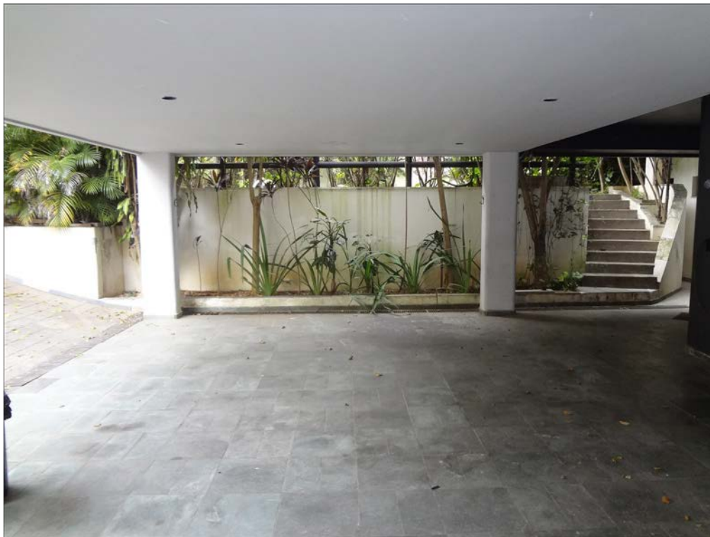
A foto ilustra a garagem (subsolo) do imóvel objeto da lide pela Rua Irmão Gonçalo nº 31, no bairro Jardim das Bandeiras.
