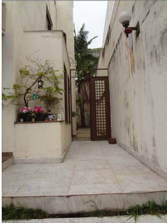
A foto ilustra parcialmente a fachada lateral direita do imóvel objeto da lide situado na Rua Irmão Gonçalo nº 31, no bairro Jardim das Bandeiras.
