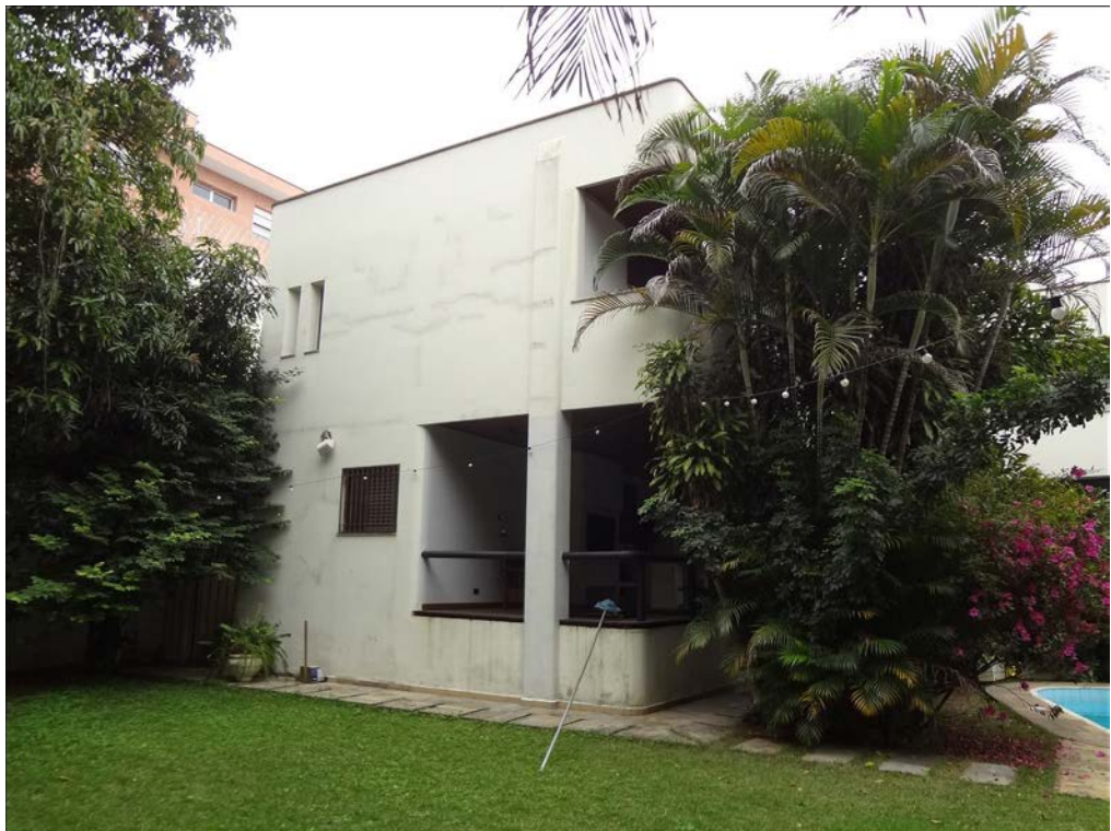
A foto ilustra parcialmente a fachada lateral esquerda do imóvel objeto da lide, situado na Rua Irmão Gonçalo nº 31, no bairro Jardim das Bandeiras.
