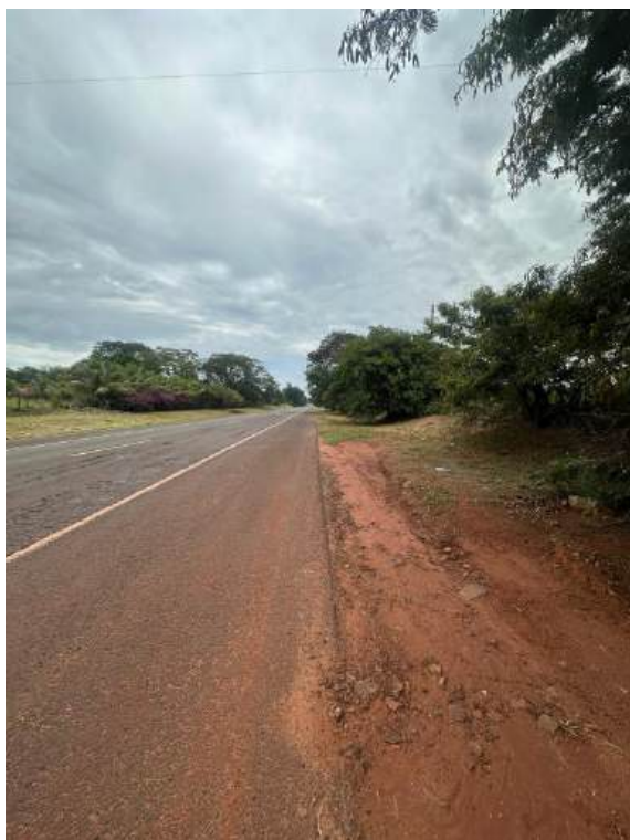
Foto 08 Via de Acesso FIRMINO BARBOSA DE OLIVEIRA (Frente), olhando do Vertice 03 para o seguimento do Vertice 04.
