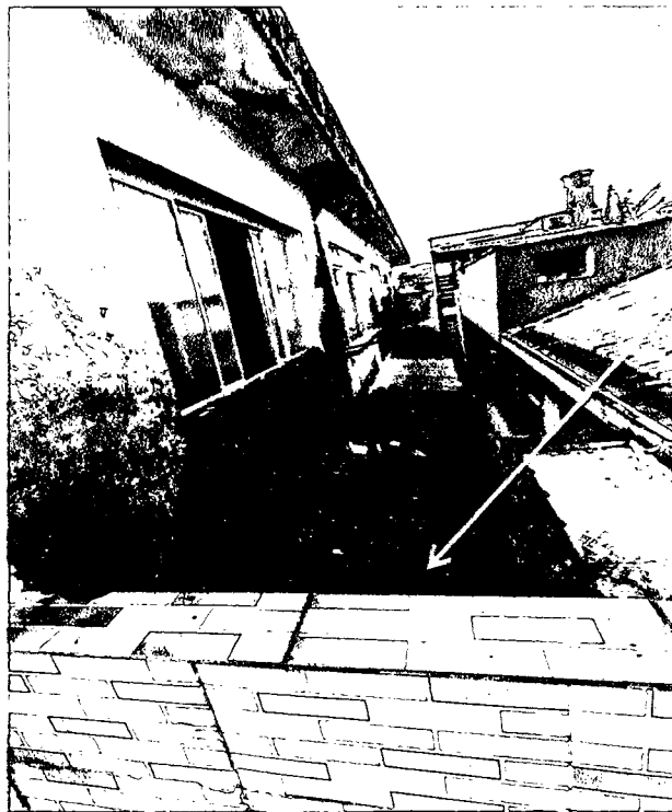
Foto 13 – Recuo lateral e cobertura da parte térrea (imóvel vizinho)
