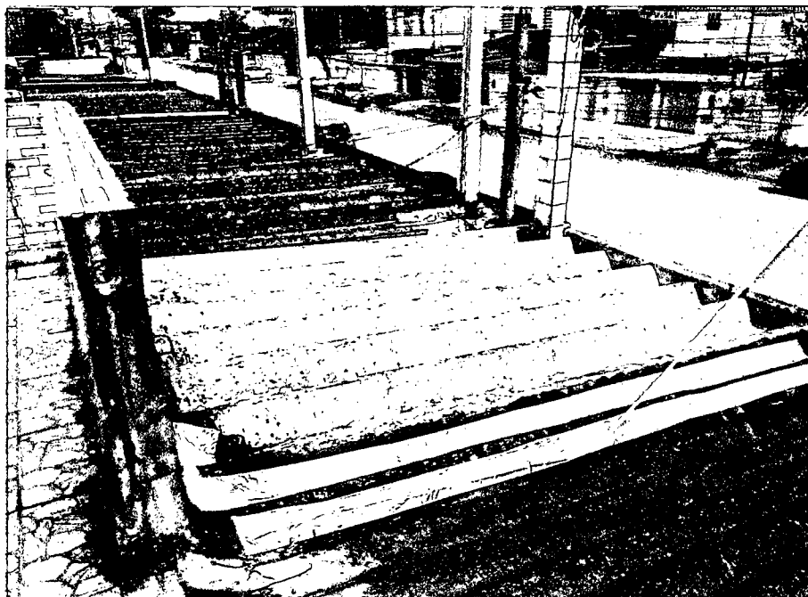
Foto 11 – Detalhe da cobertura da garagem em canaletes, com remendos diversos
