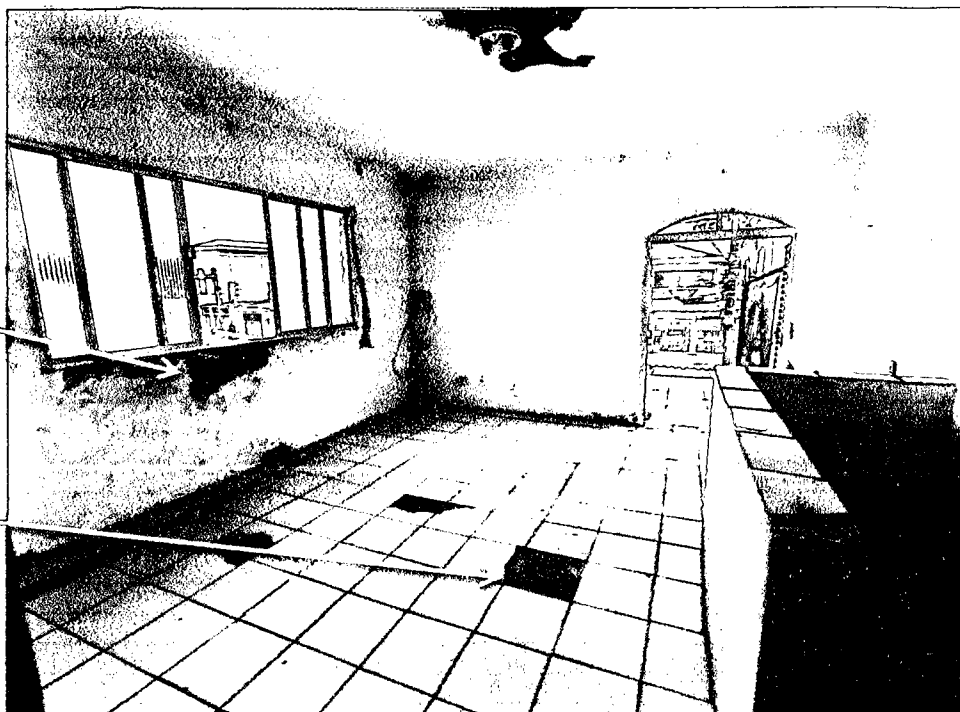
Foto 8 – Sala do imóvel, mostrando danificações no piso e paredes
