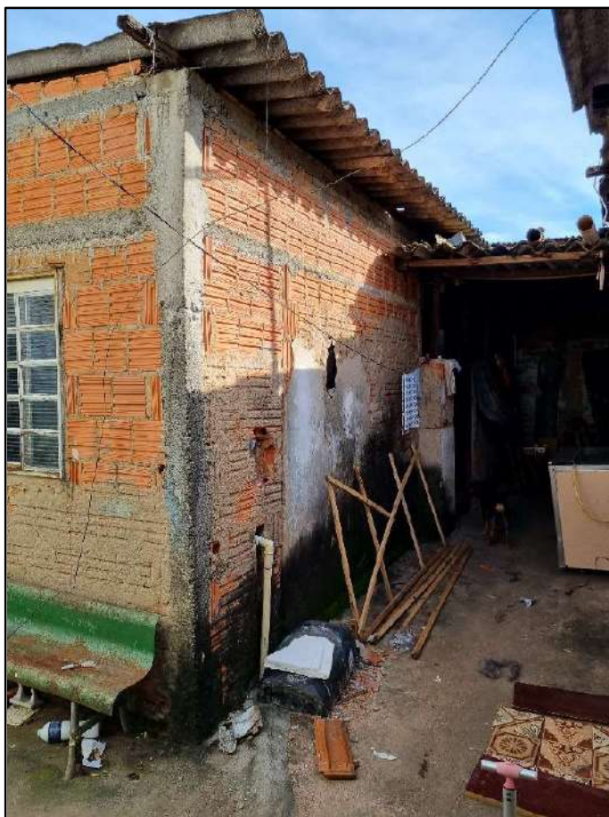
FOTO 26 – VISTA EXTERNA DA CASA 02/03.
