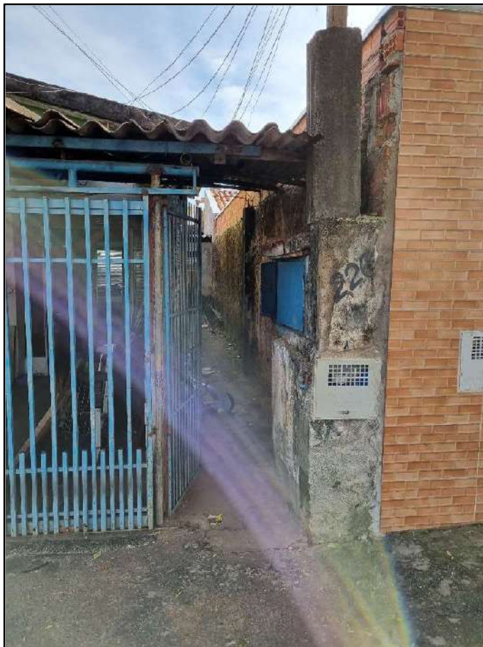
FOTO 23 – CORREDOR DE ACESSO ÀS EDIFICAÇÕES SITUADAS NOS FUNDOS DO TERRENO (CASAS 01, 02 E 03).
