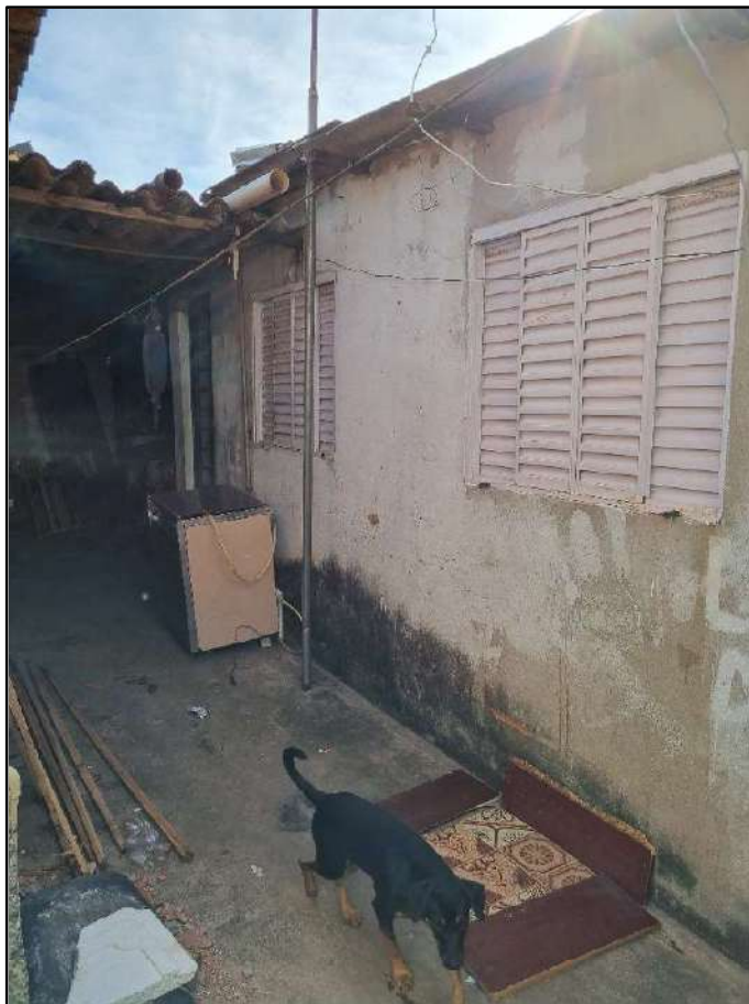
FOTO 40 – VISTA EXTERNA DA CASA 04.
