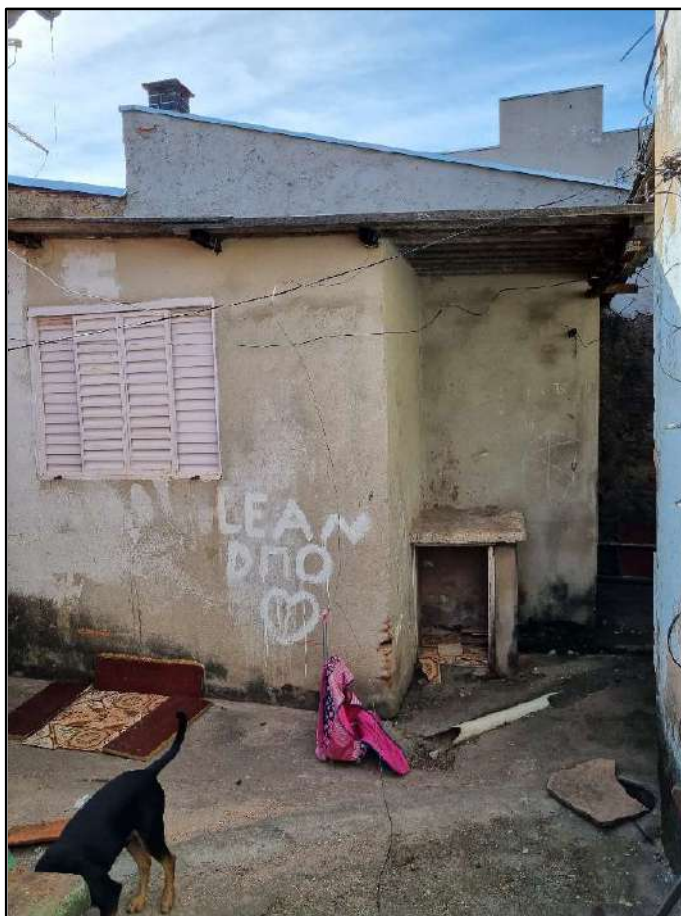
FOTO 41 – VISTA EXTERNA DA CASA 04.
