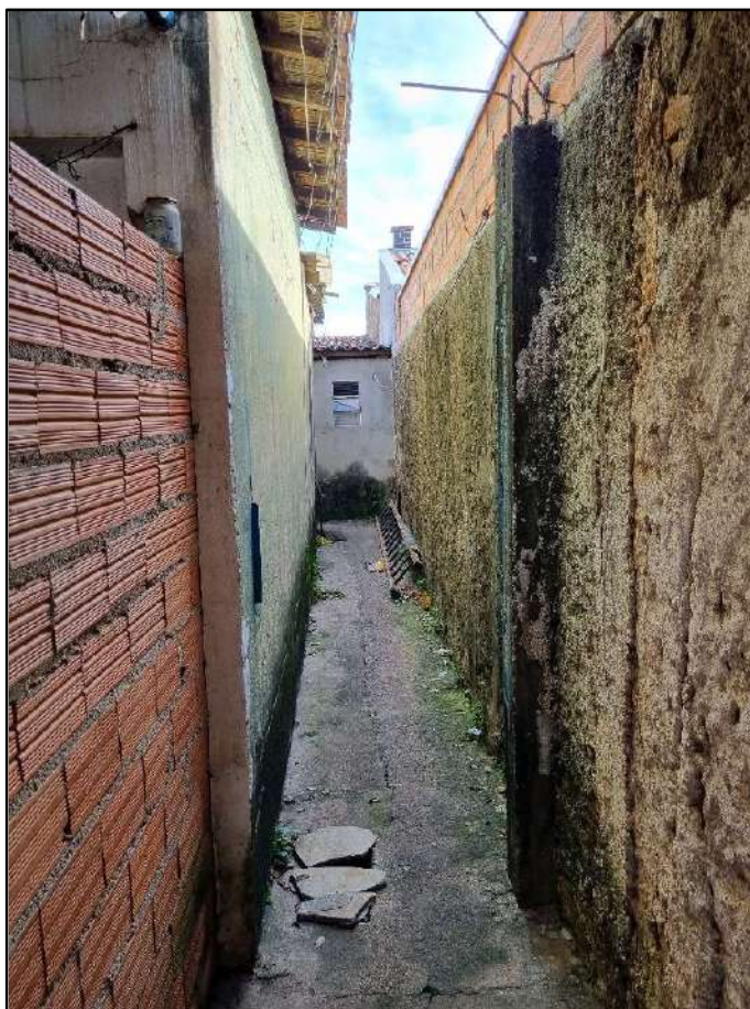
FOTO 24 – CORREDOR DE ACESSO ÀS EDIFICAÇÕES SITUADAS NOS FUNDOS DO TERRENO (CASAS 01, 02 E 03).
