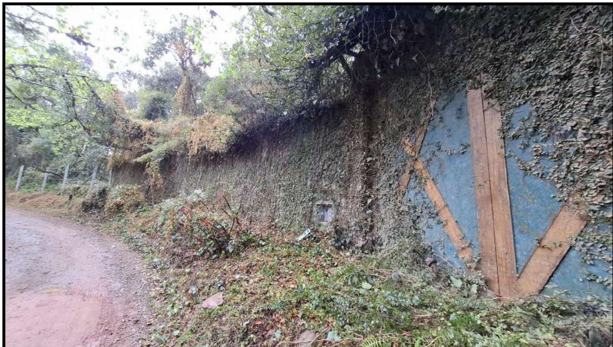
Rua Alice Abdo Bunemer - Muro e portão do lote 102 à direita da foto.
