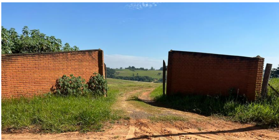
Foto 05 - Portão de Entrada
