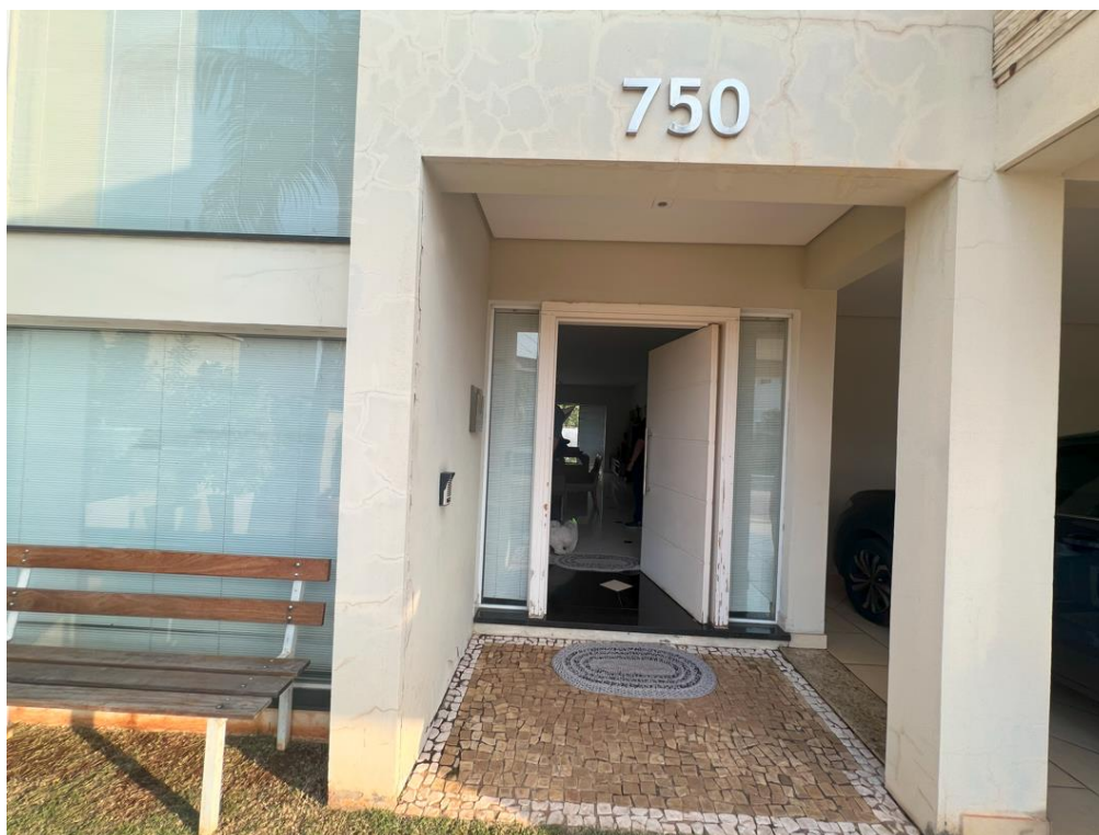
VISTA DA ENTRADA DO IMÓVEL.
