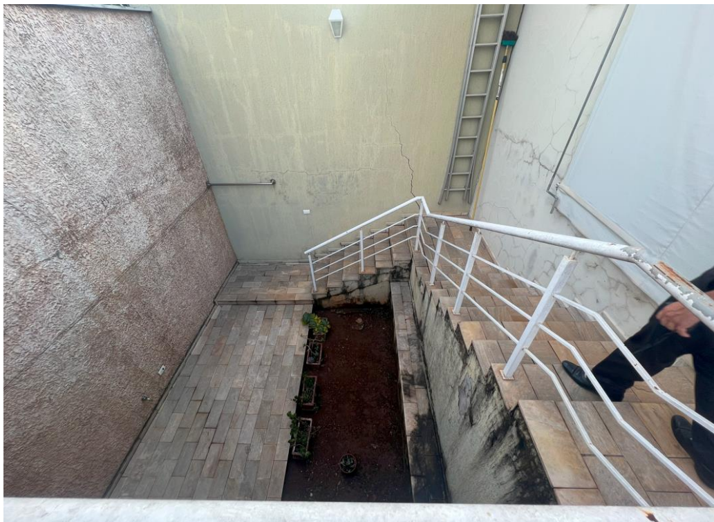
VISTA DA ESCADA DE ACESSO AO SUBSOLO.
