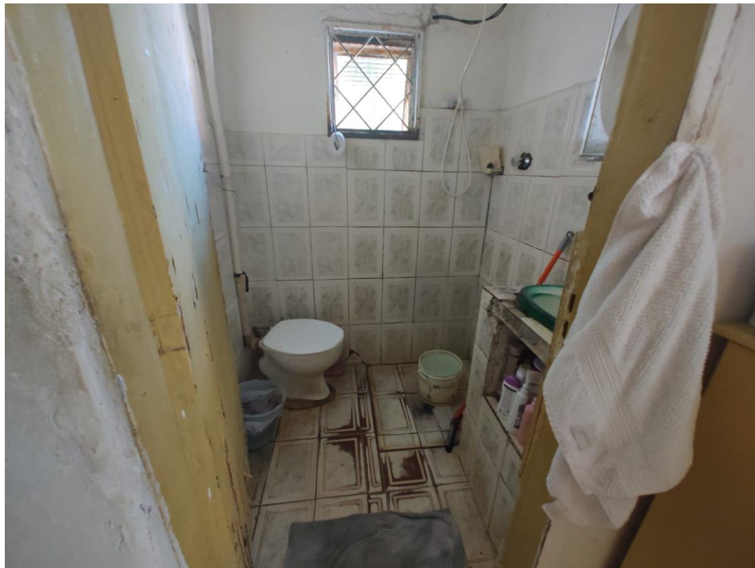
Banheiro de outro ângulo.
