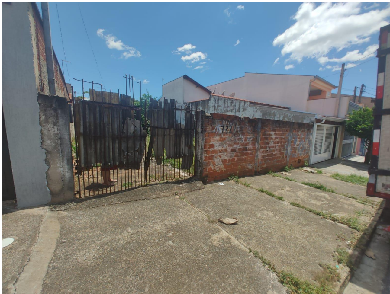
Vista da rua para frente do Imóvel Avaliando
