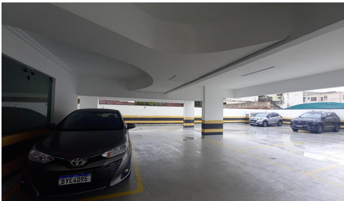
Foto 04. Vista do estacionamento do Edifício Office Tower
