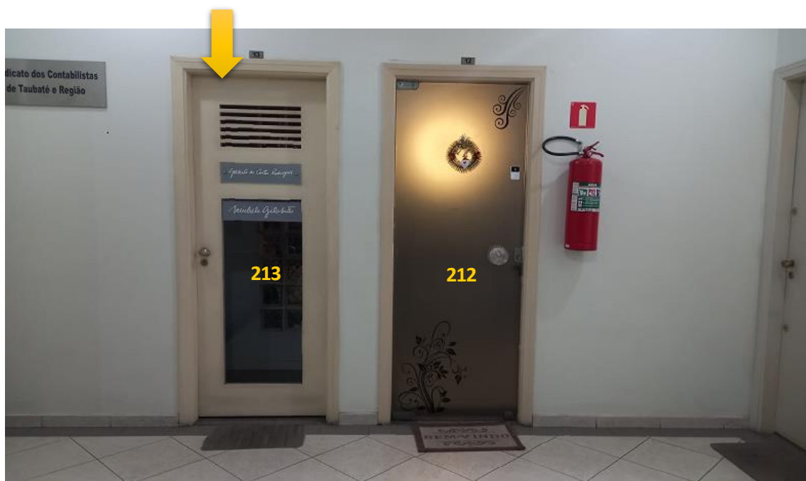
Foto 15: Vista das portas das Salas 12 e 13
