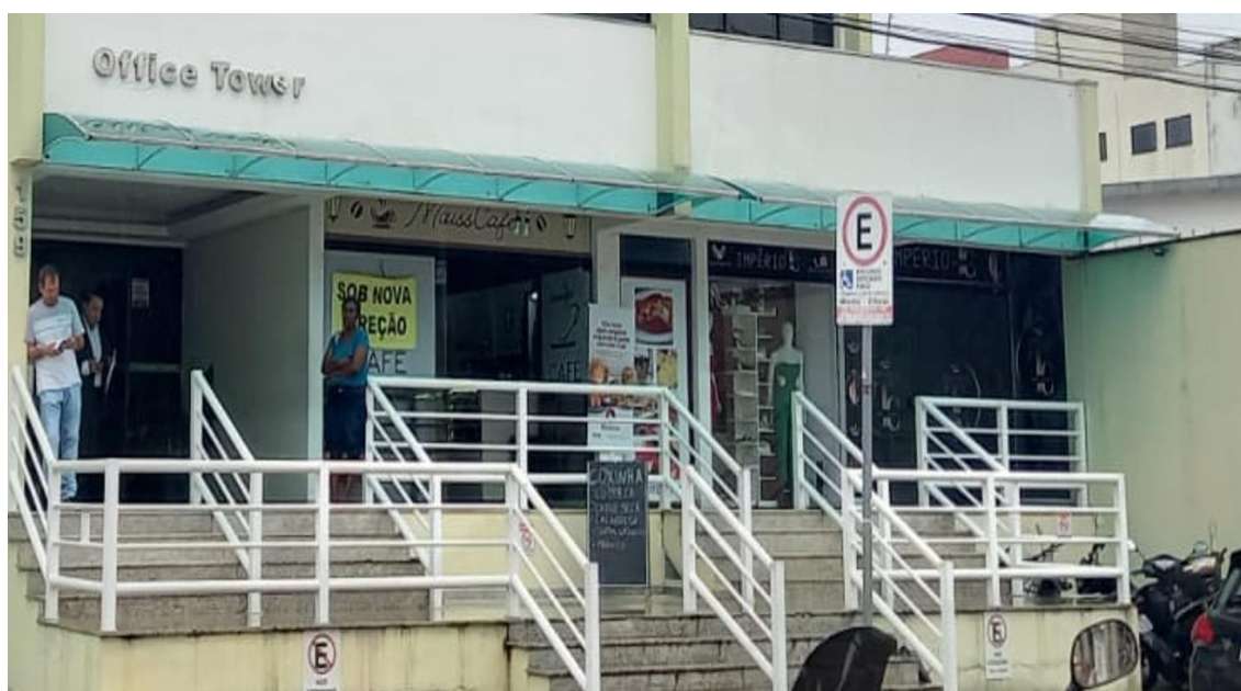
Foto 05. Vista das lojas do Edifício Office Tower
