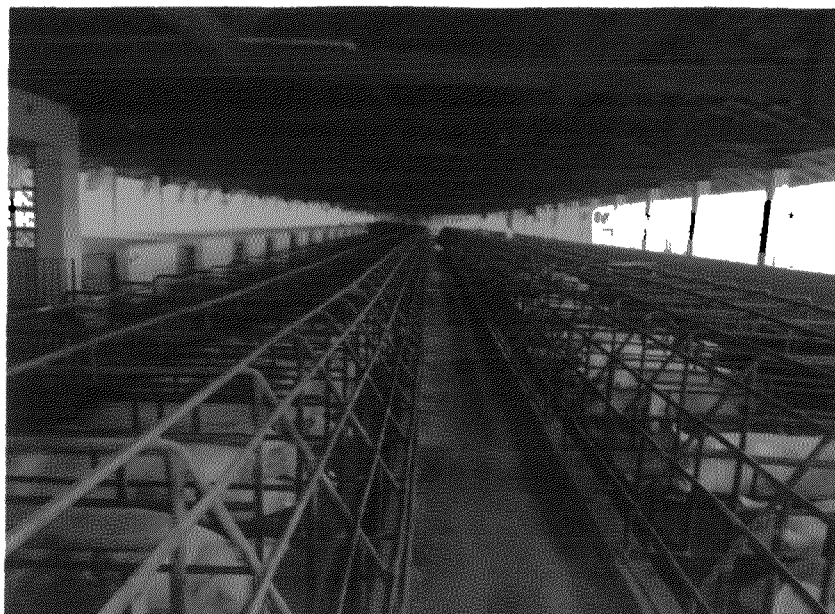
Imagem 9. Granja de Suínos – Gestação.
