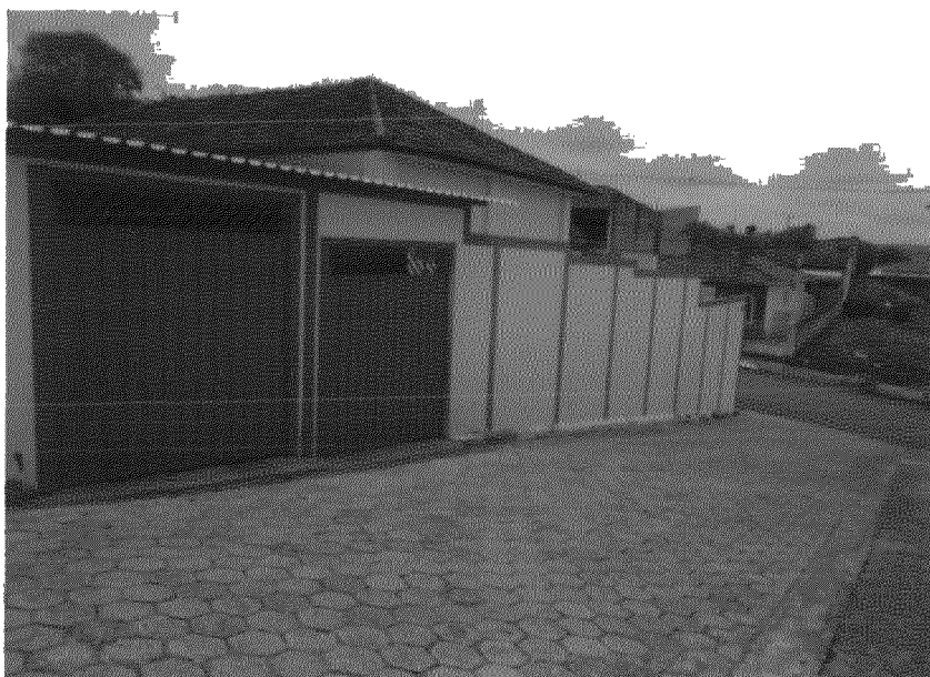
Imagem 34. Vista lateral com os dois portões (não eletrônico) da garagem.
