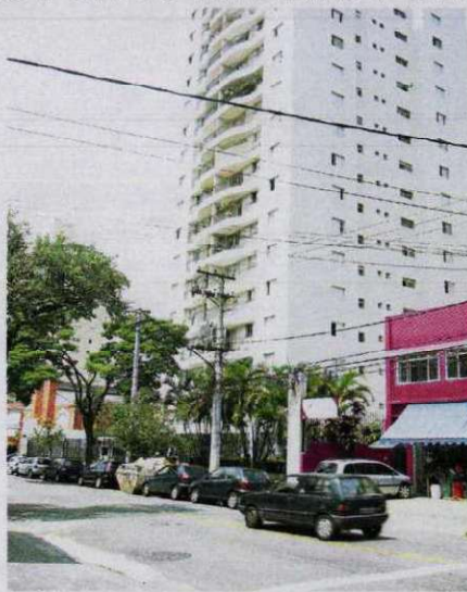
FOTOS 2 E 3 - VISTAS DA FACHADA DO PRÉDIO.
