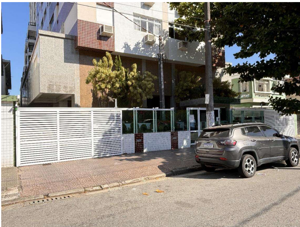
Figura 4: Vista dos acessos ao condomínio.
