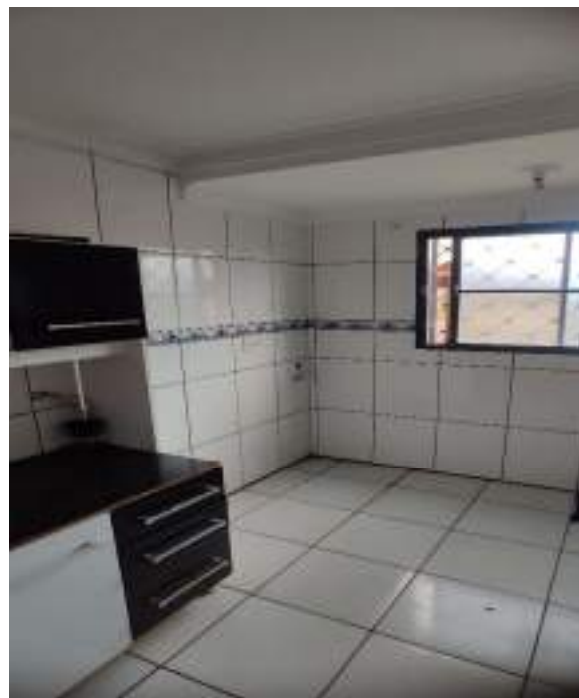
Foto 5: Cozinha em Piso ceramico, acabamento ceramico até o teto, Laje premoldada concreto, sanca em gesso e Pintura Latex
