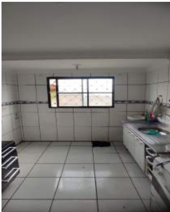
Foto 5: Cozinha em Piso ceramico, acabamento ceramico até o teto, Laje premoldada concreto, sanca em gesso e Pintura Latex
