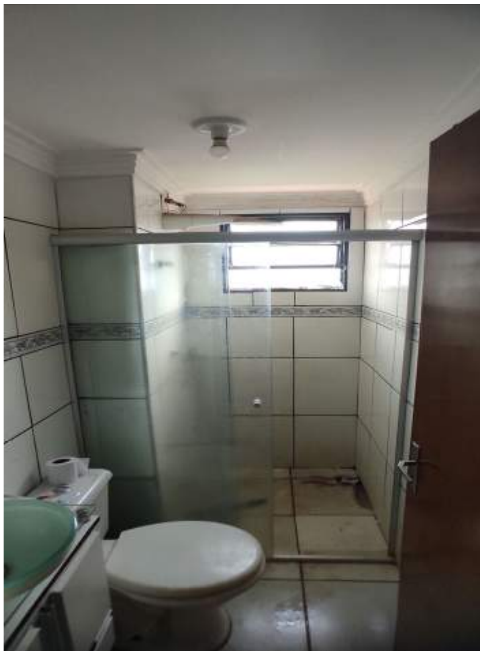
Foto 6: Banheiro em Piso ceramico, acabamento ceramico até o teto, Laje premoldada concreto, sanca em gesso, box de Vidro e Pintura Latex
