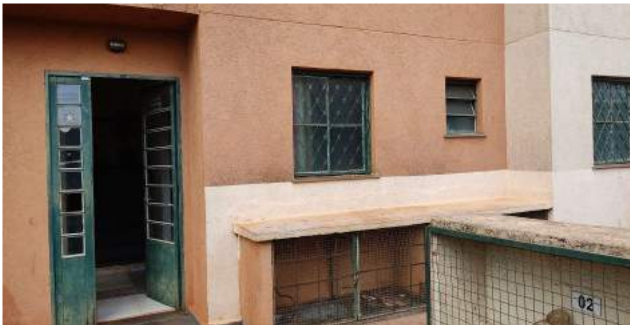
Foto 02: Hall de Entrada do Bloco 03 Apto 02 térreo
