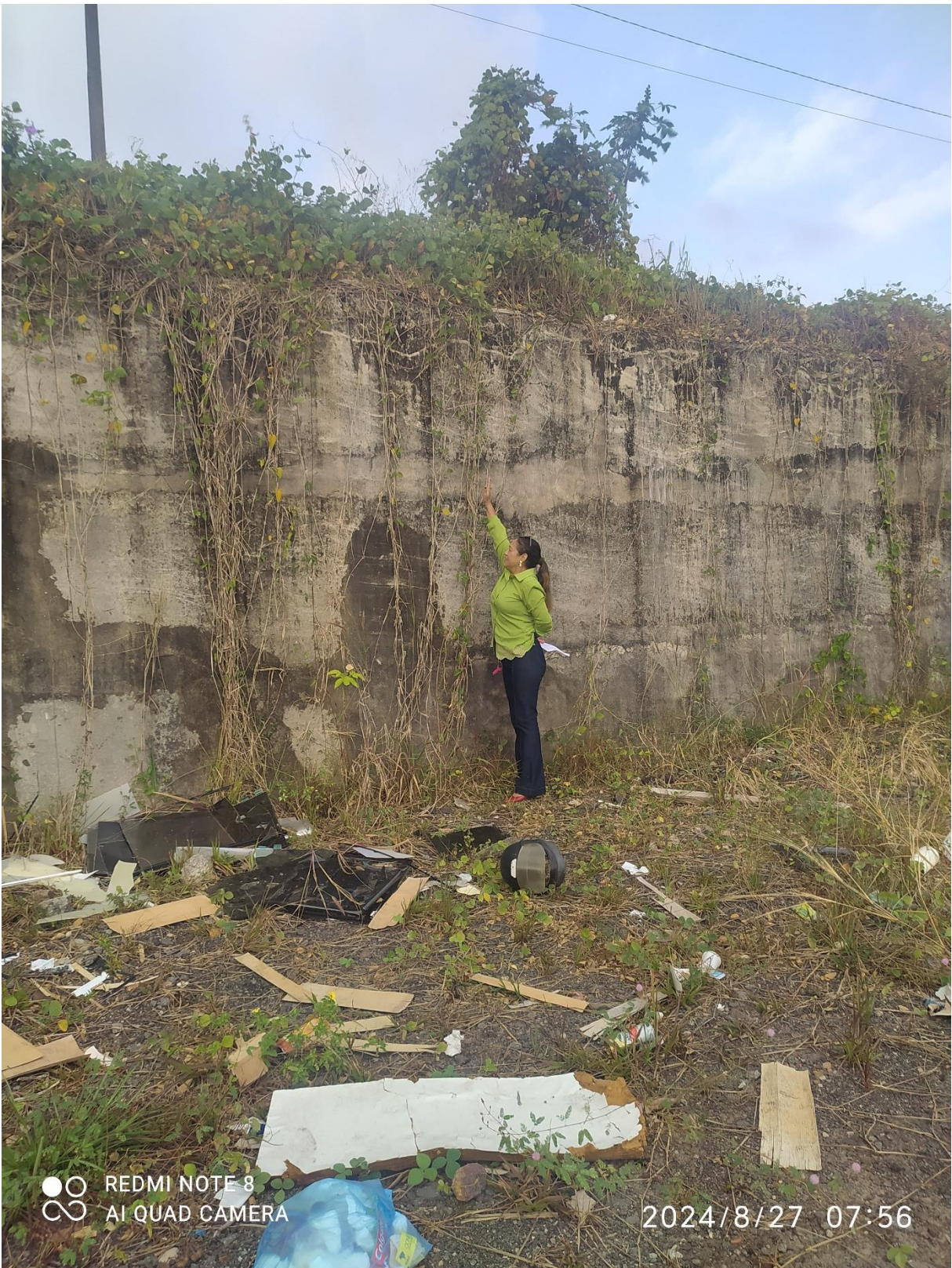
Foto 10 – Imagem interna do muro de arrimo
