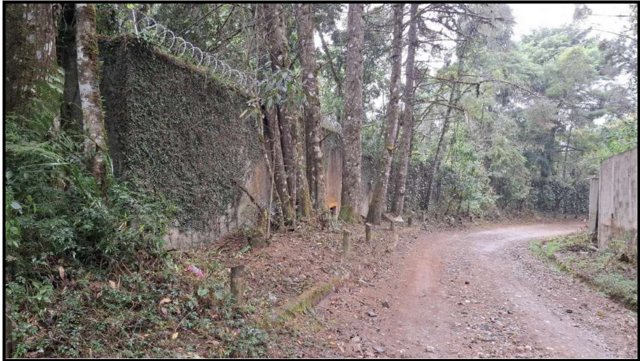
Rua 10 - Muro dos lotes 101 e 102 à esquerda da foto.
