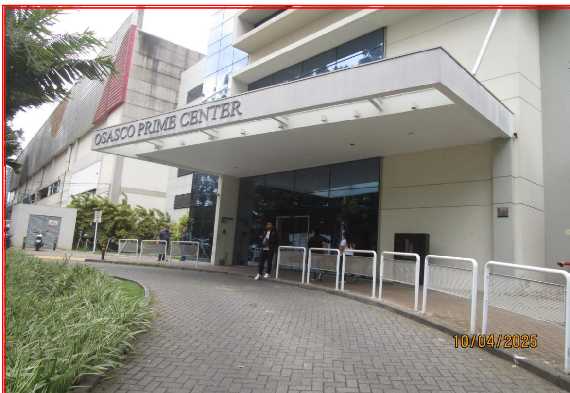
Foto nº 04: Vista geral do acesso a portaria e recepção, voltada para a Av. Franz Voegeli.
