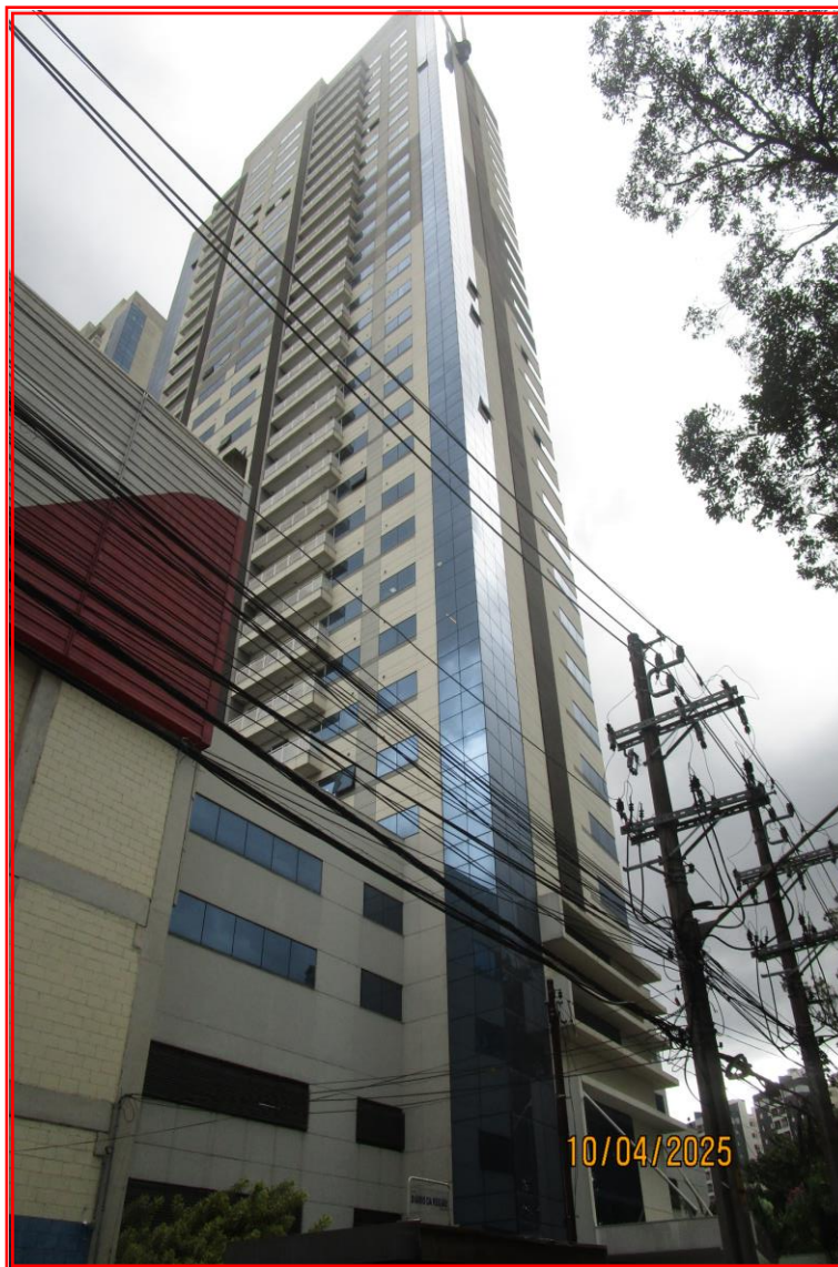
Foto nº 02: Vista geral da fachada da Torre 1 “Santorini”, onde se localiza o imóvel avaliando.
