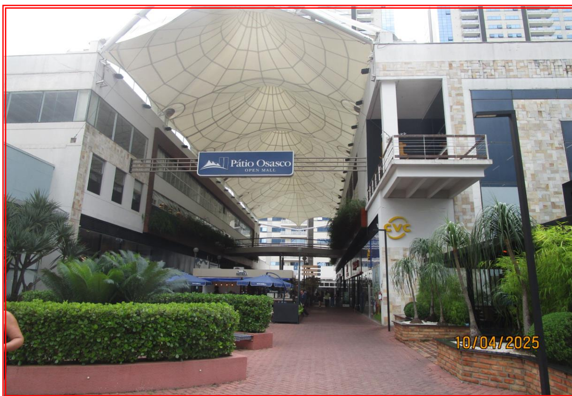
Foto nº 19: Vista geral do acesso ao Pátio Osasco Open Mal.
