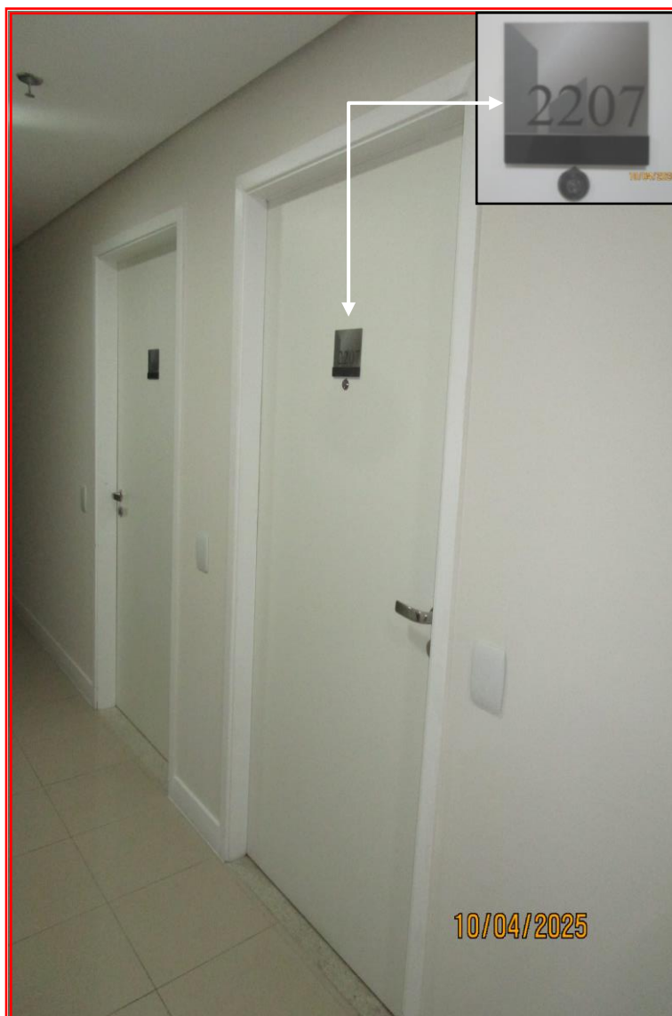
Foto nº 12: Vista geral da porta do escritório 2207, objeto da avaliação. Na oportunidade da vistoria, se encontrava fechado.
