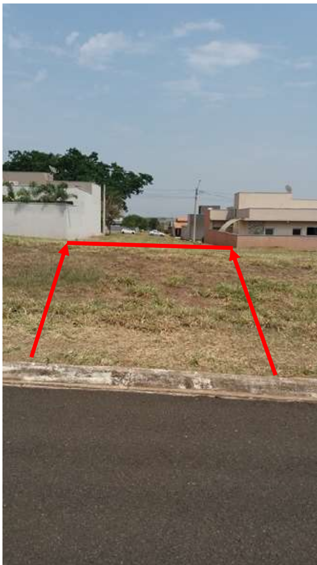
FOTO 05 – Vista do imóvel na Rua 12 s/nº, Lote 16, da Quadra 19 – Residencial Bella Vittà Monte Líbano.
