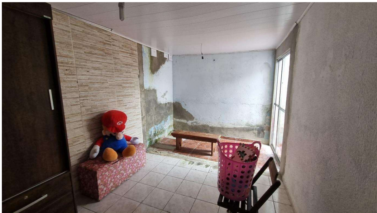
Vista parcial dormitório sala
