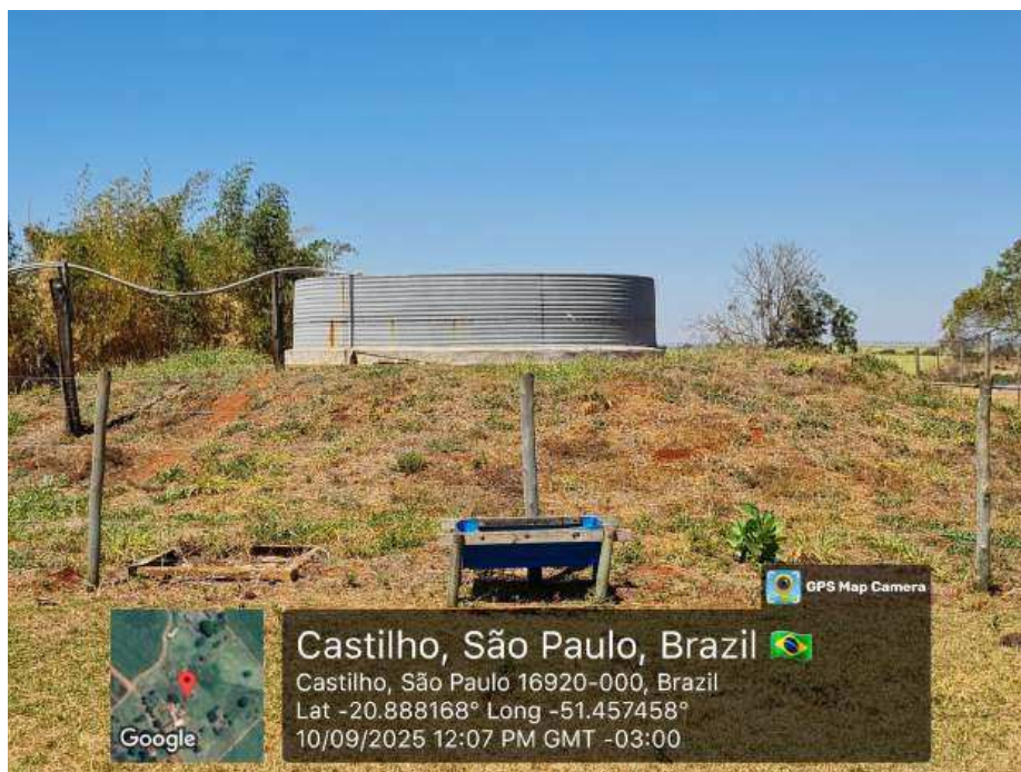
Foto 27 – Reservatório Tipo Australiano
