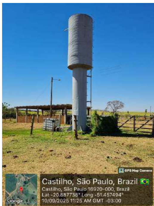
Foto 26 – Reservatório e Poço
