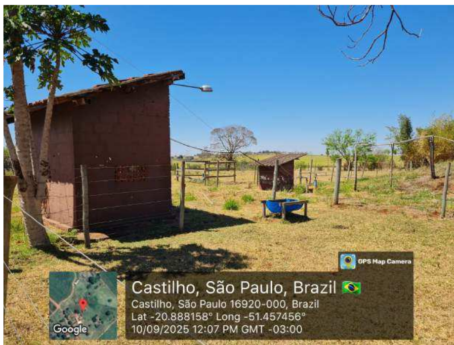
Foto 16 – Casa de maquina, Poço e Ferramentaria
