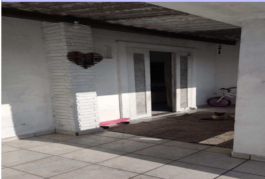
Foto 3 - RECUO FRONTAL - PORTA ACESSO A SALA
