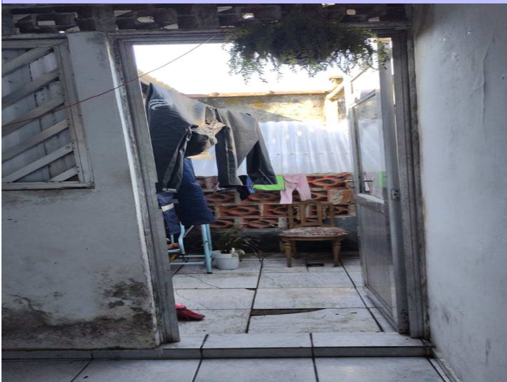
Foto 9 - PORTA DE ACESSO A RECUO FUNDOS DESCOBERTO
