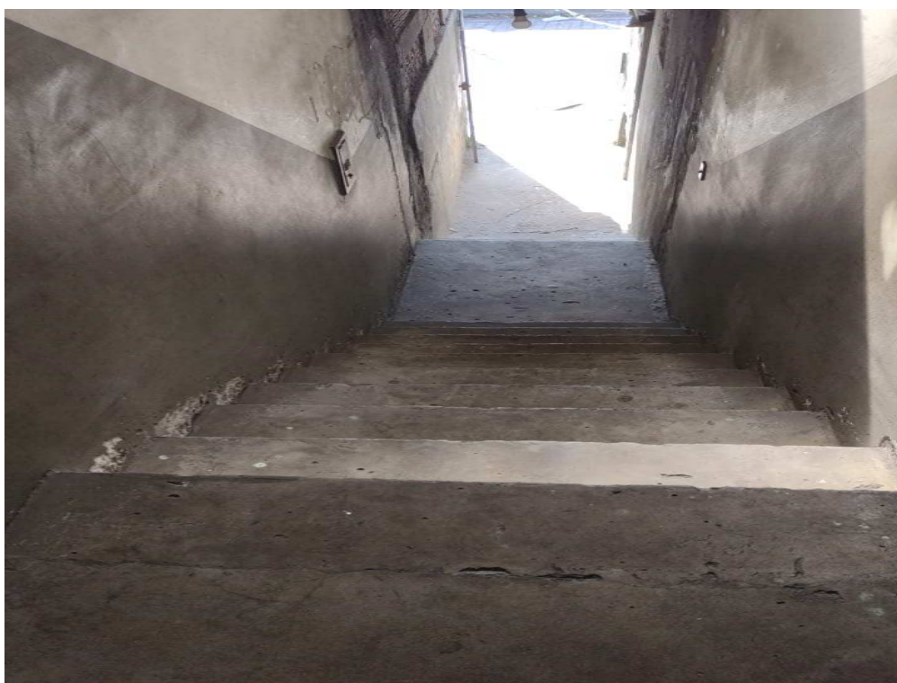
Foto 4 - ESCADARIA DE ACESSO AO IMÓVEL
