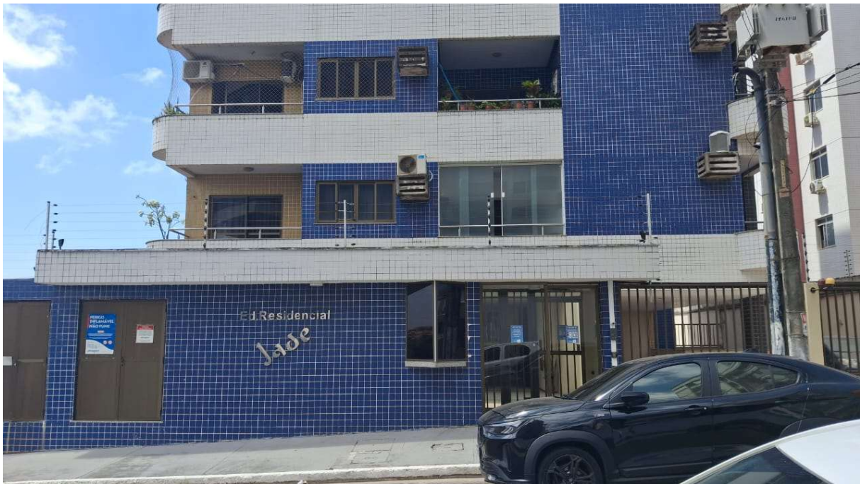
FOTO 2 FACHADA DO CONDOMÍNIO
