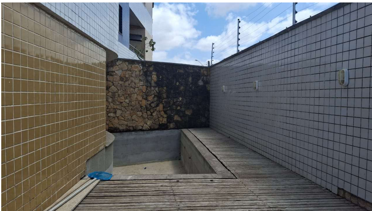
FOTO 5 ÁREA DE PISCINA EM REFORMA
