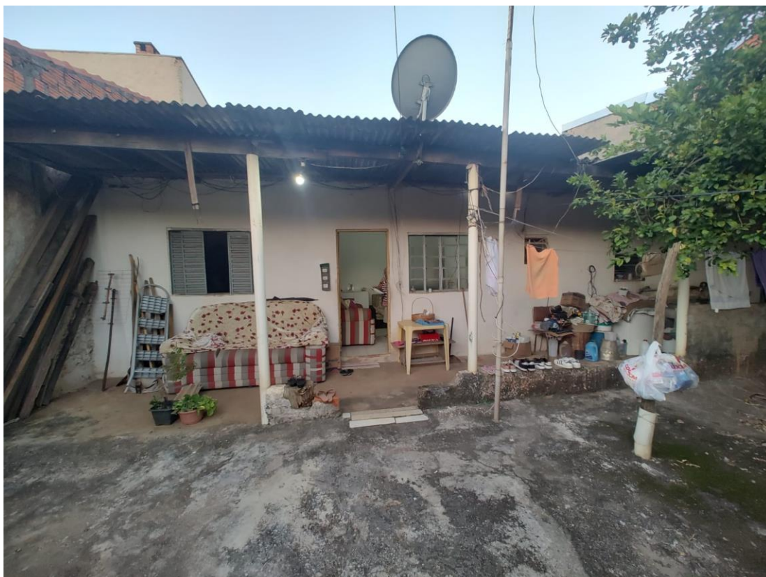
Frente do Imóvel Avaliando
