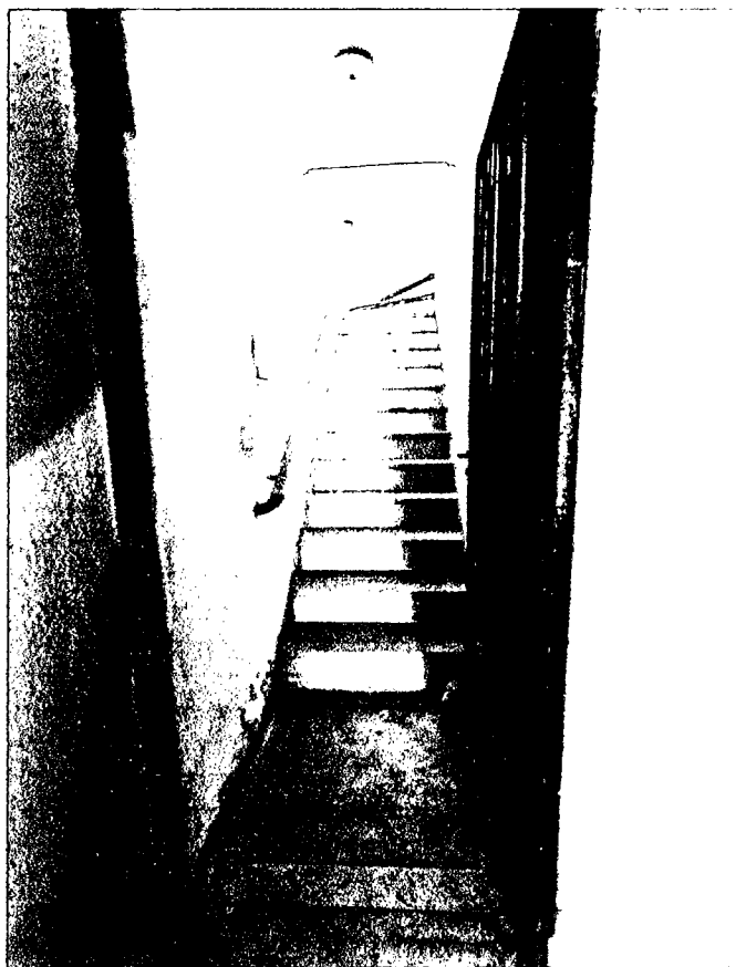
Foto 7 – Escada de acesso ao segundo pavimento
