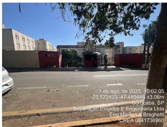
Foto 1 – Portaria do Condomínio
