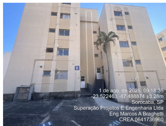
Foto 2 – Fachada do “Bloco 11”
