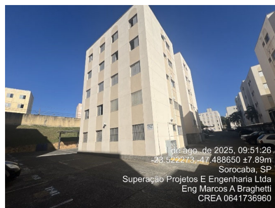
Foto 16 – Vista da Lateral Direita e dos Fundos do “Bloco 11”
