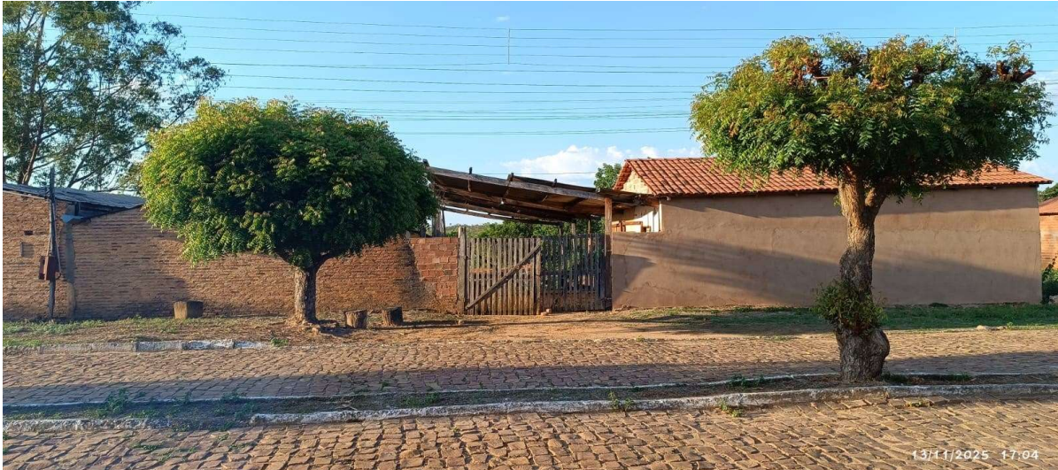
IMAGEM FRONTAL DA ENTRADA DO TERRENO
