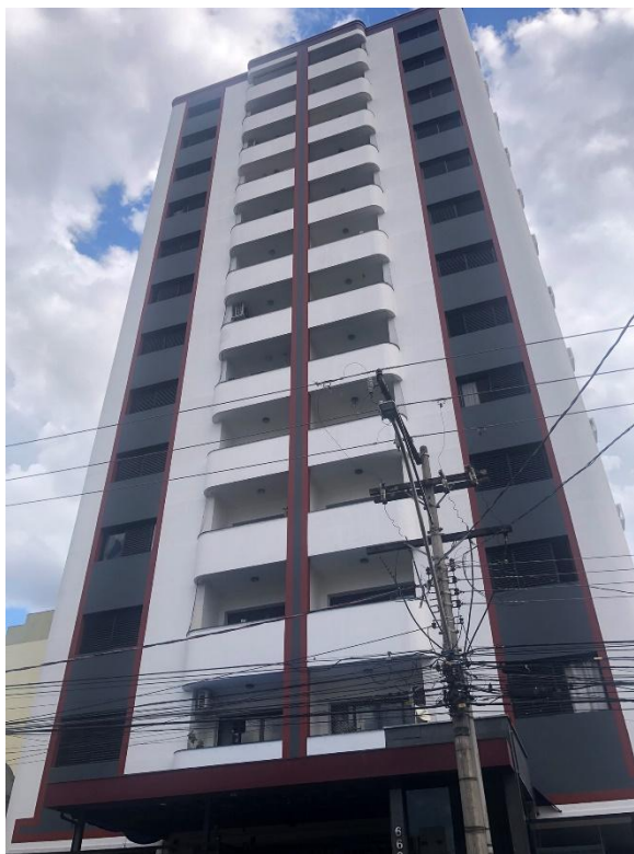
VISTA DA FACHADA DO EDÍFICIO.
