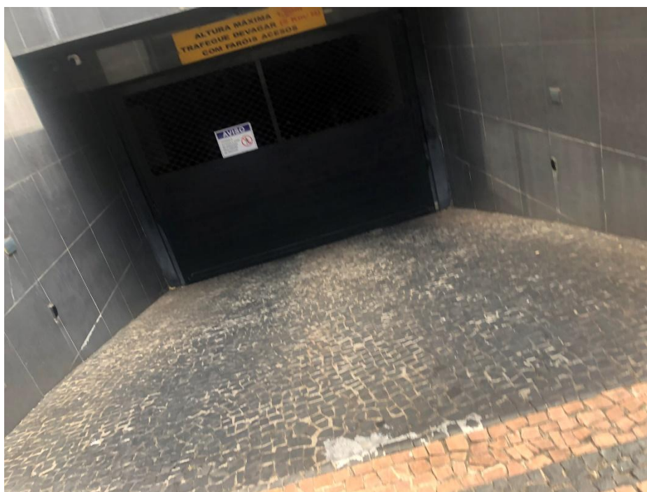
VISTA DO ACESSO ÀS VAGAS DE GARAGEM.
