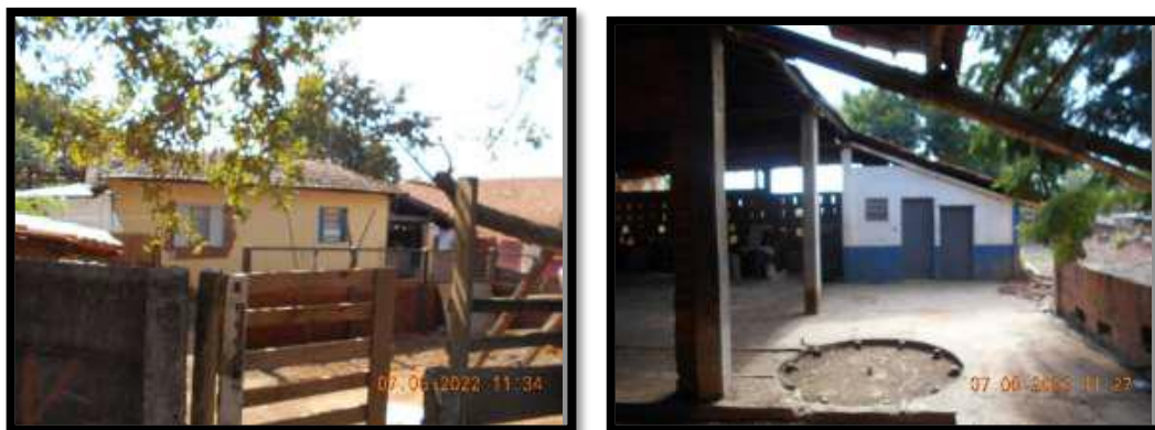
Figuras 8,9,10,11,12,13,14, 15 e 16 - Fotos do imóvel avaliando (Fonte: autos do processo)
