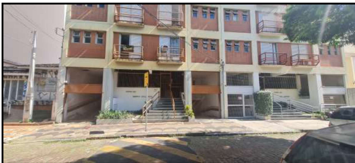
2. Identificação do Edifício Serra Dourada e do acesso à portaria e ao subsolo garagem.
