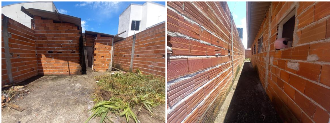
Fotos 14 e 15: Vistas da ausência de acabamento nas paredes da fachada e muros.
