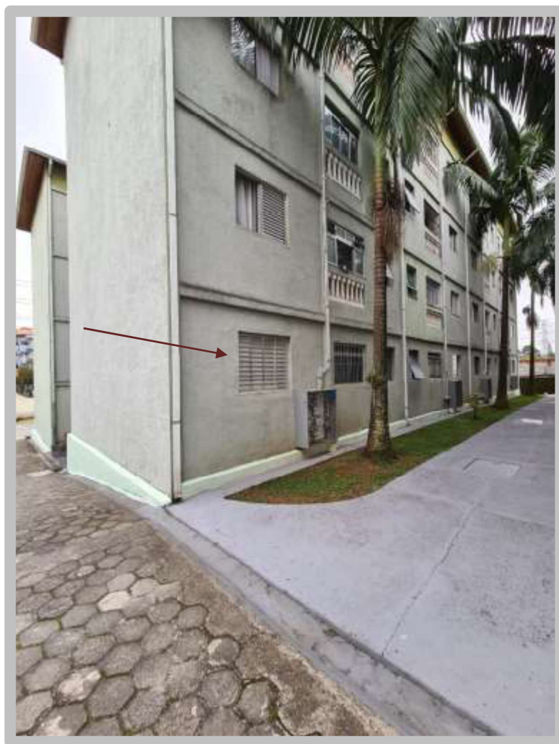
Vista dos fundos do bloco 296, localizado o apartamento avaliando n. 13.
