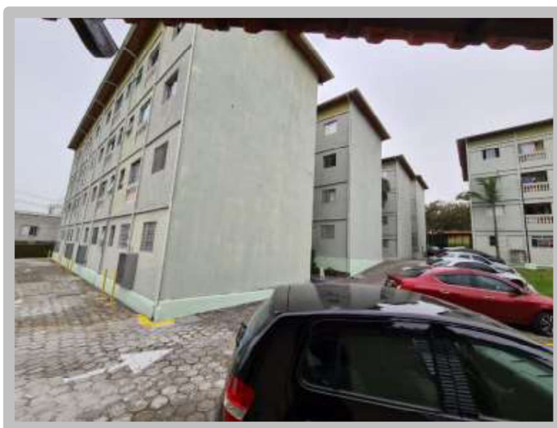
Vista do edifício localizado o apartamento avaliando.
