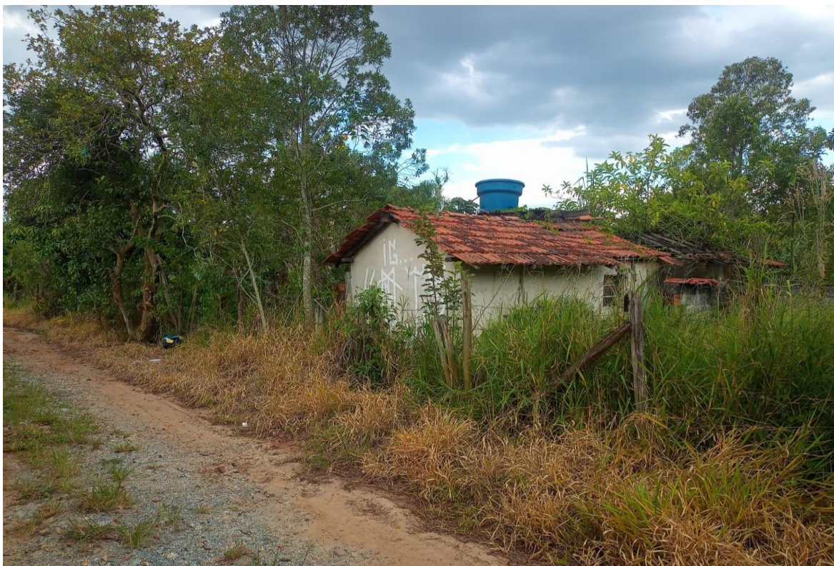
Foto 3: Vista frontal do imóvel avaliando.
