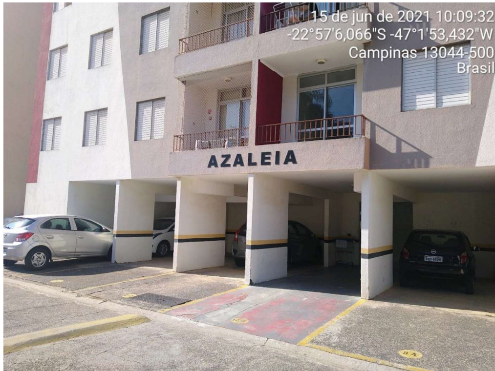
FOTO 09 – TORRE DO IMÓVEL AVALIANDO
