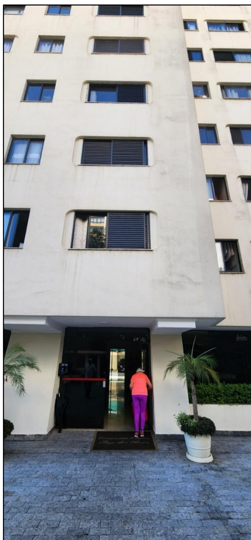
Foto 01 – Fachada do Condomínio
