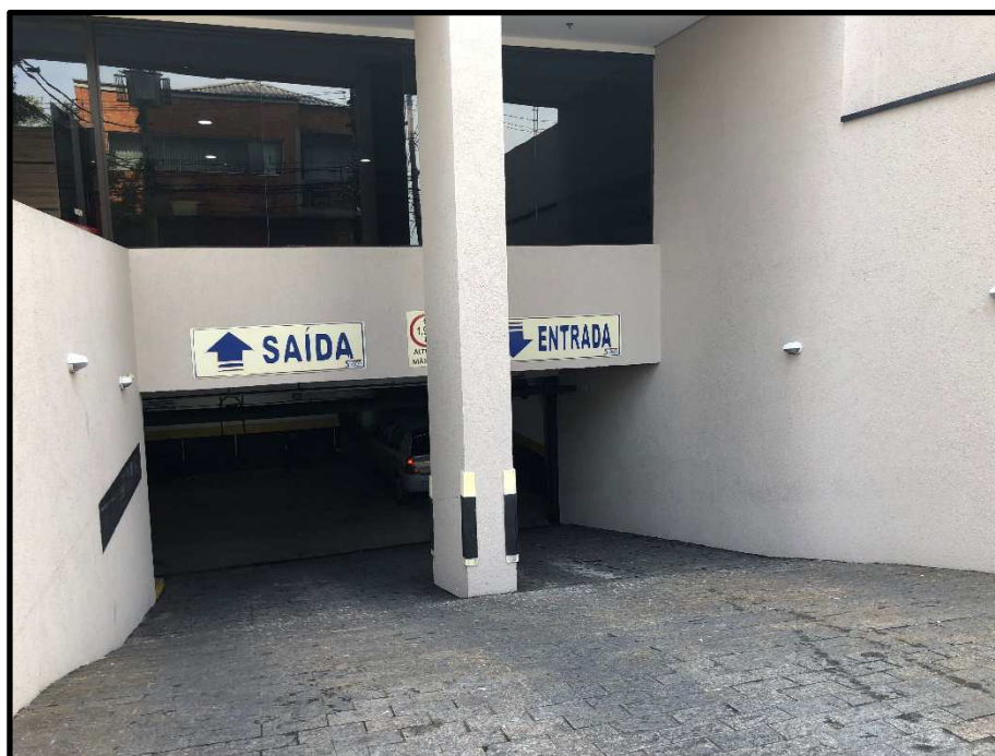
Foto 4 – “THE OFFICE BROKFIELD” – entrada do estacionamento
