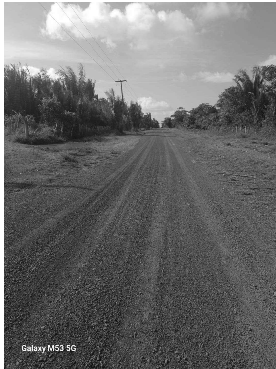
Foto 01 – Detalhe de estrada cascalhada de boa qualidade à propriedade
