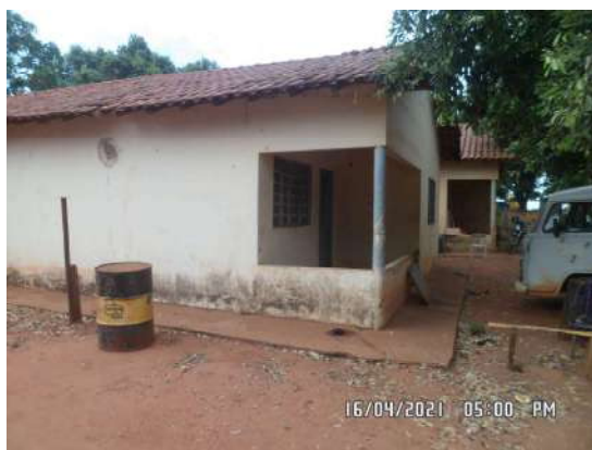
Foto 12: Edificação em alvenaria-Área=95,90m 2 x 2 um = 191,80m 2 .
