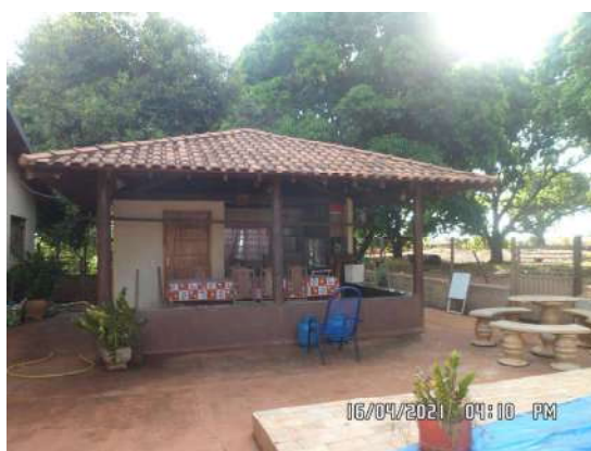
Foto 10: Vista do quiosque (Estado de conservação: BOM).
