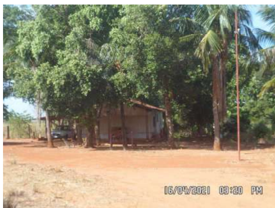
Foto 20: Idem, edificação de empregado-madeira.
