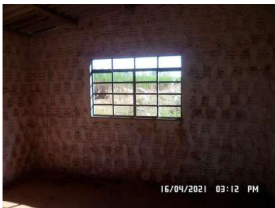
Foto 22: Idem, edificação de empregado-alvenaria.
