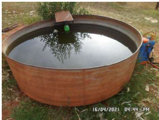
Foto 25: Reservatório de água, tipo circular, capacidade 4.000 litros, estado de conservação REGULAR.
