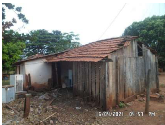
Foto 14: Vista do barraco (Estado de conservação: MAU).
