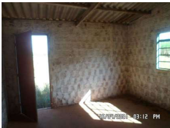
Foto 21: Edificação de empregado-alvenaria.
