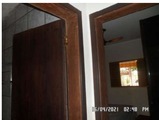
Foto 11: Ilustração dos acessos entre banheiro 1 e dormitório 1.
