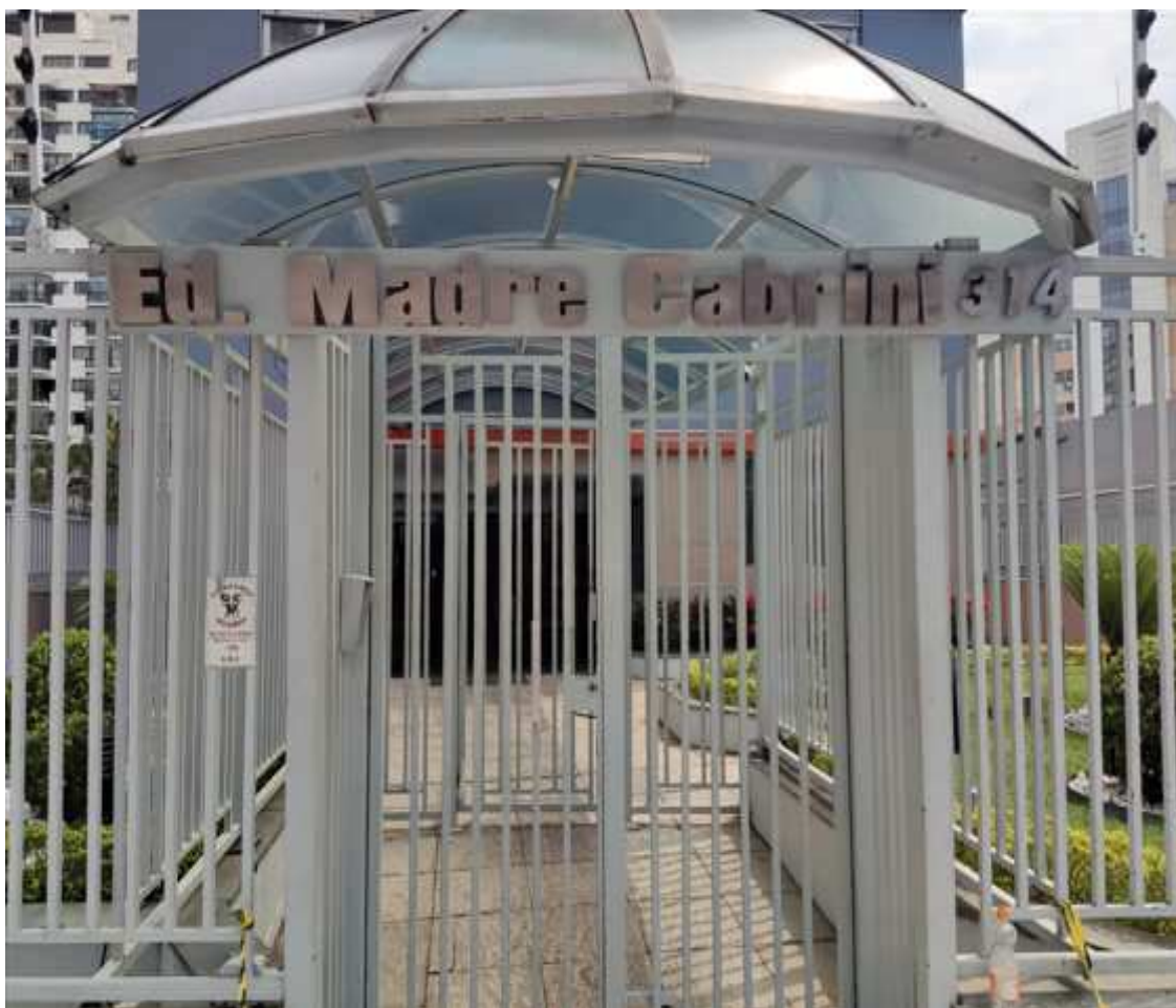
Vista do Imóvel Avaliando
