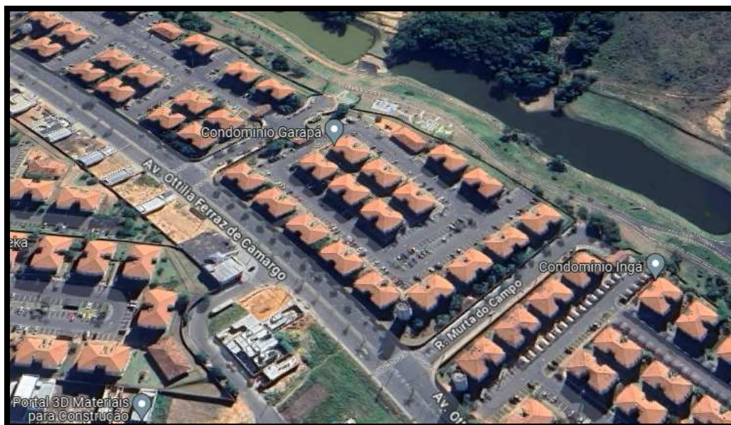
Imagem GoogleMaps - Condomínio Residencial Garapa - Indaiatuba
