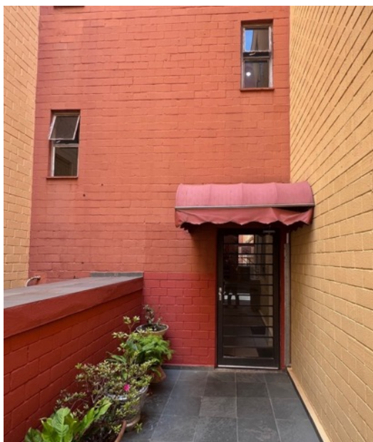
Imagem 09: Entrada para o Bloco B
