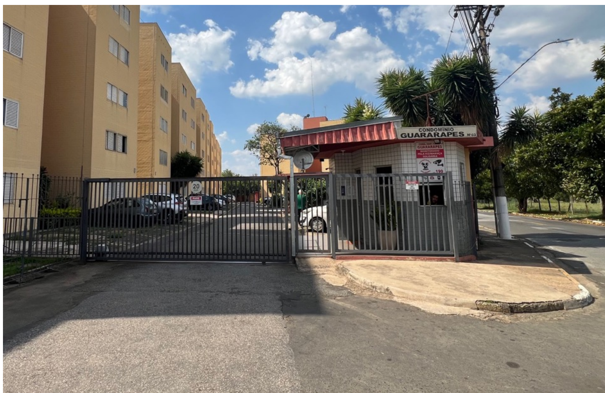
Imagem 01: Fachada do condomínio com entrada para pedestres e veículos através de portaria exclusiva
