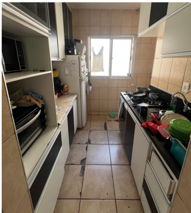
Imagem 15: Cozinha do apartamento. Mais ao fundo, lavanderia
