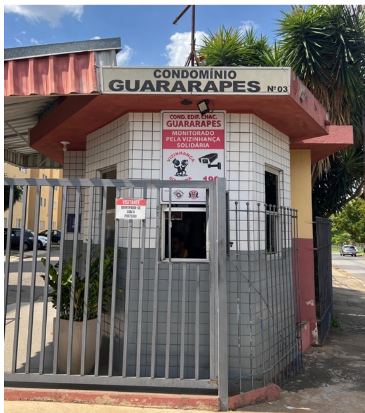
Imagem 02: Portaria do empreendimento com letreiro do condomínio
